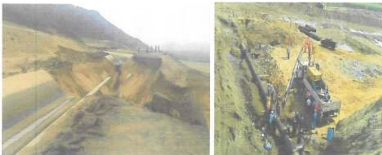
ROTURA DEL CANAL MADRE QUE ABASTECE DE AGUA A LA PLANTA DE TRATAMIENTO Y TUBERIA DE CONDUCCION DE 900mm DE DIAMETRO.
