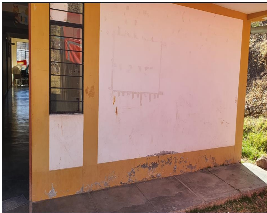
FOTO N°4 SE OBSERVA PINTURA EN MAL ESTADO EN LA FACHADA DEL PUESTO DE SALUD
