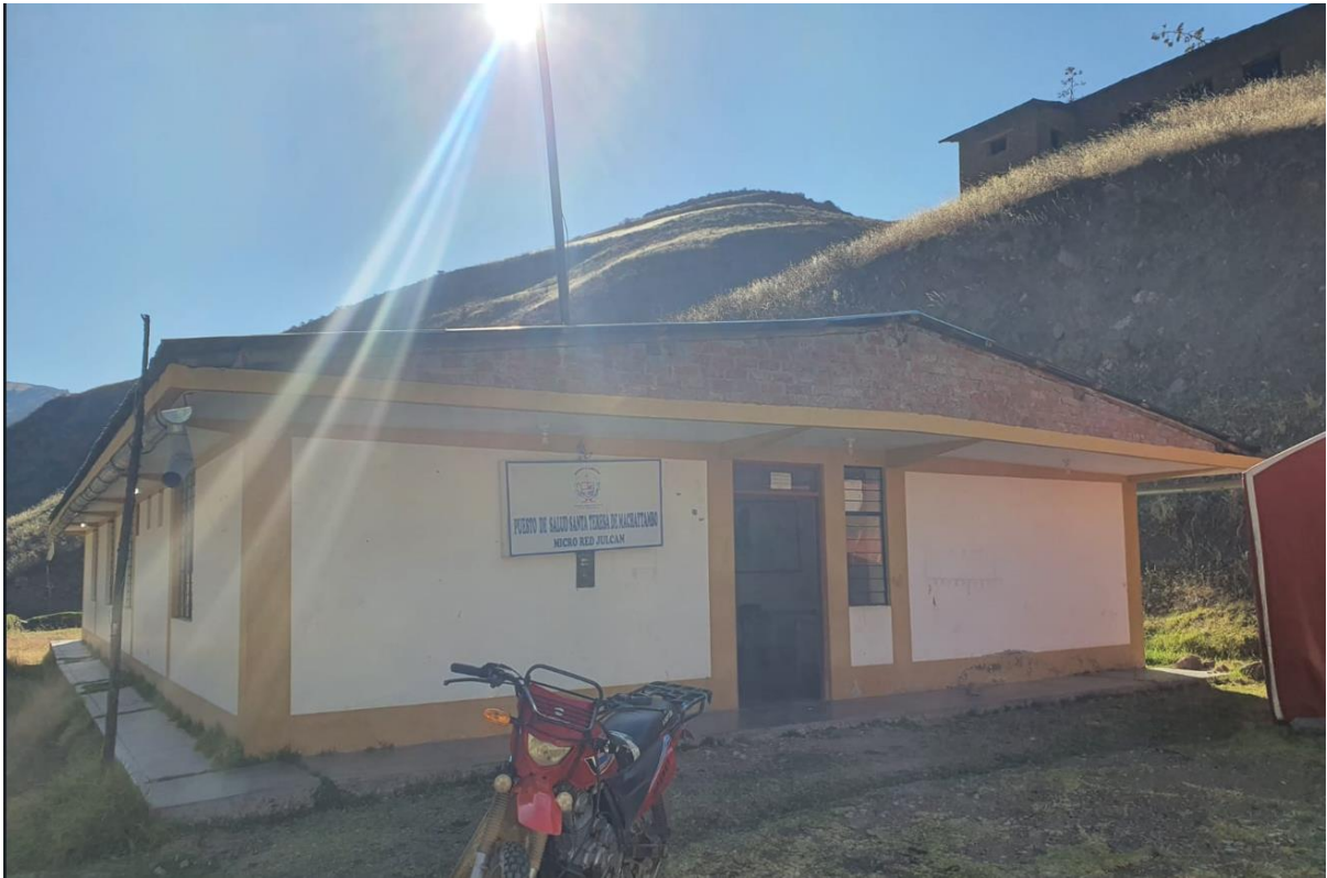
FOTO N°1 FRONTIS DEL PUESTO DE SALUD, SE OBSERVA PINTURA EN MAL ESTADO EN LA FACHADA DEL PUESTO DE SALUD
