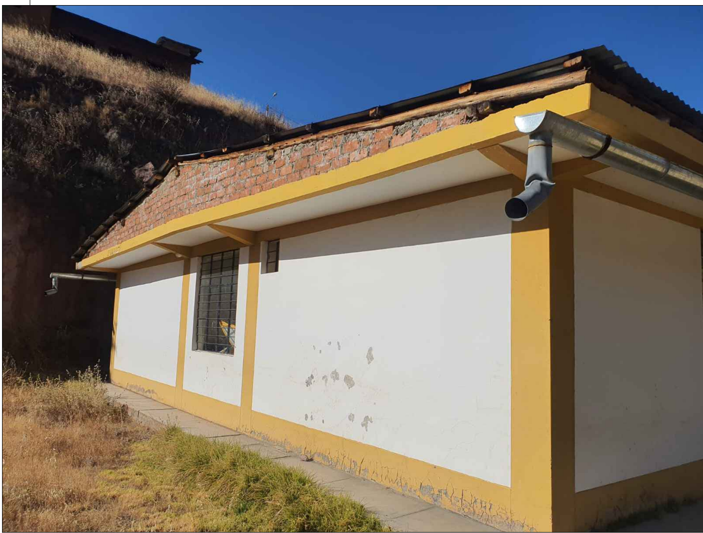
IMAGEN N1: SE VISUALIZA LA CANALETA PLUVIAL OXIDADA Y MONTANTE DE FISURADA
