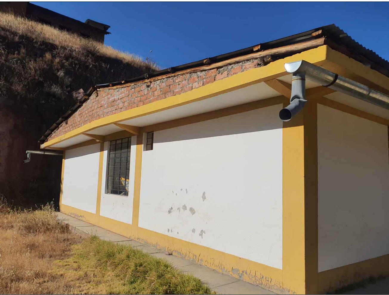
IMAGEN N°1: SE VISUALIZA LA PINTURA EN LOS MUROS EXTERIORES EN MAL ESTADO, CANALETA OXIDADA Y TUBERIA DE EVUACION PLUVIAL FISURADA
