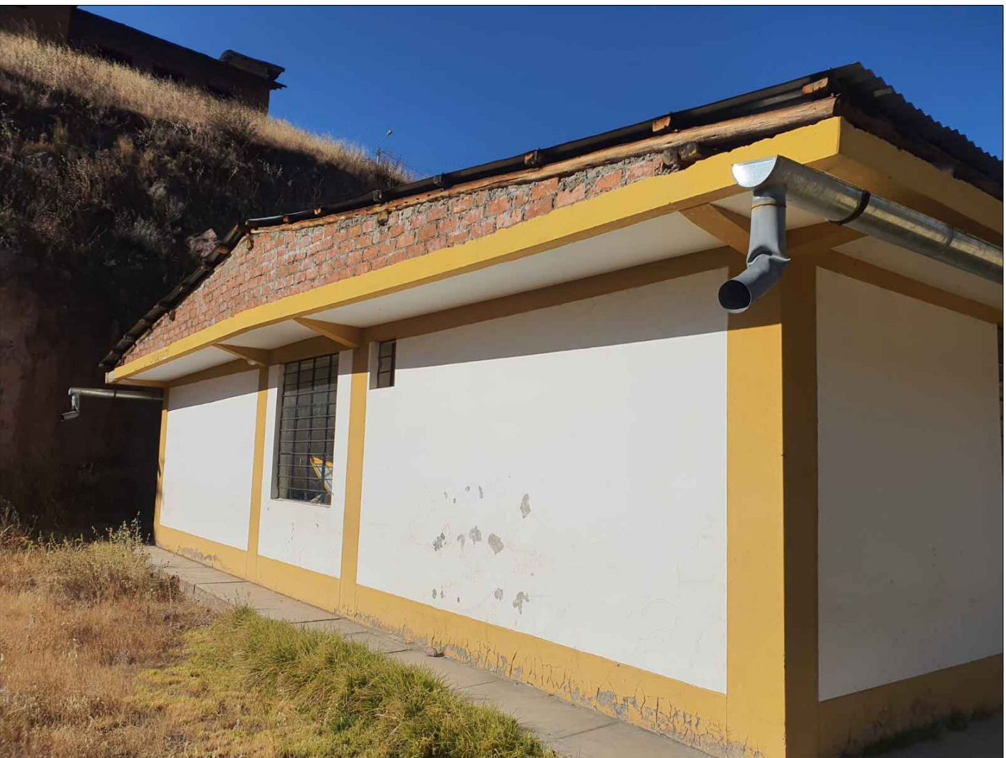
IMAGEN N°3 : SE VISUALIZA CANALETA PLUVIAL EN MAL ESTADO Y MONTANTE PLUVIAL RAJADO
