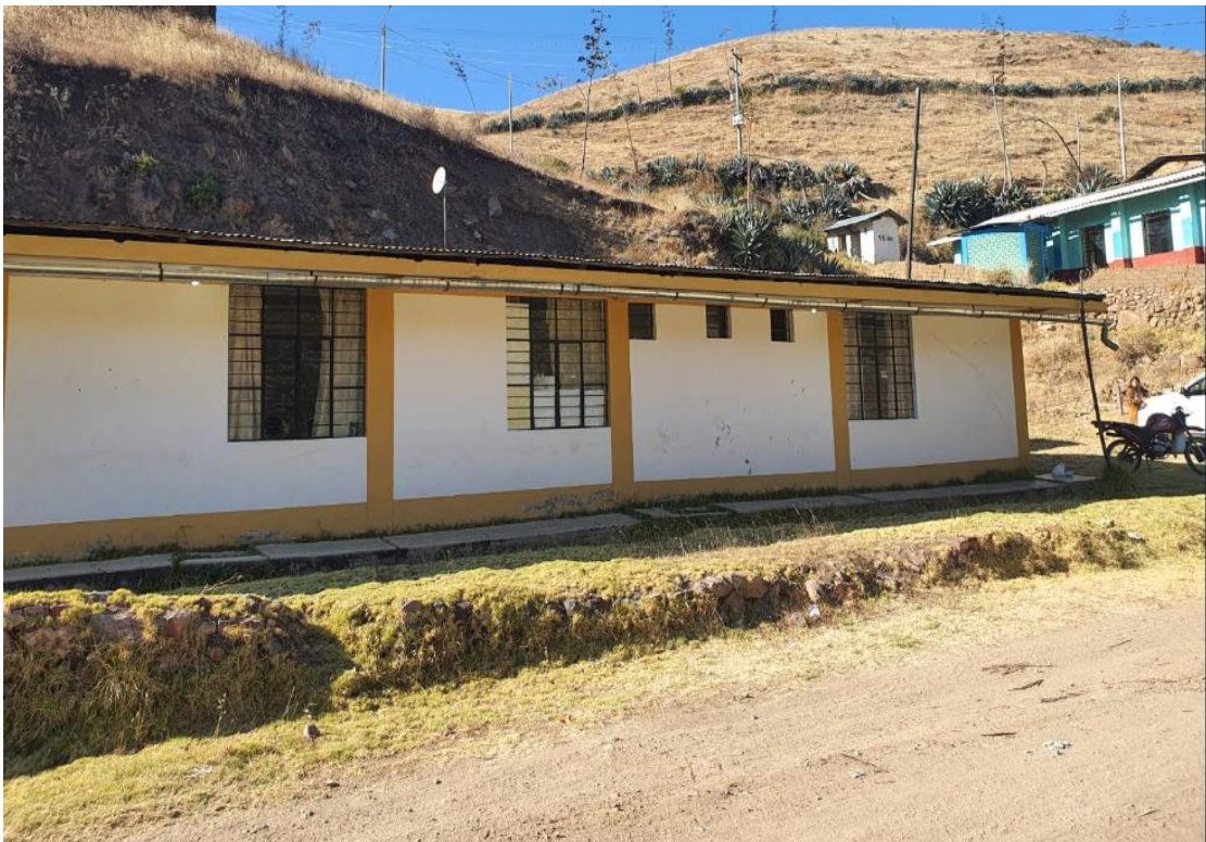
FOTO N°12 SE OBSERVA LA CANALETA OXIDADA EN MAL ESTADO.
