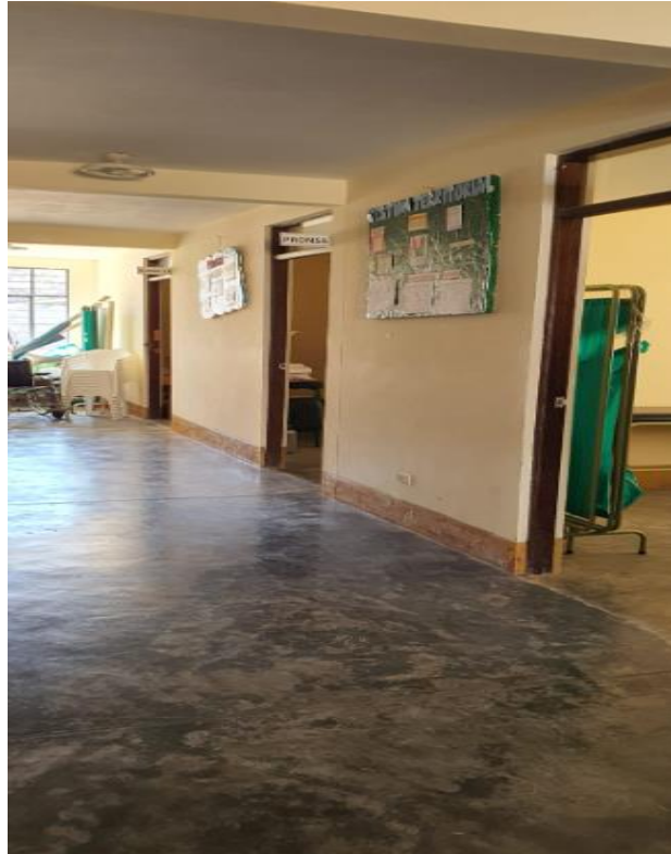
FOTO N°21 SE OBSERVA PISO DE CEMENTO PULIDO
