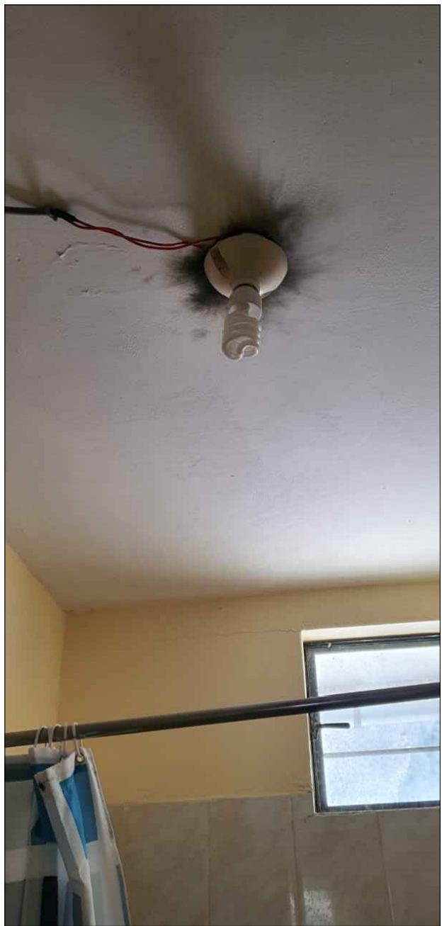
IMAGEN N°1Y2 : CABLES EXPUESTOS Y FOCOS DE PASADIZO QUE NO FUNCIONAN.
