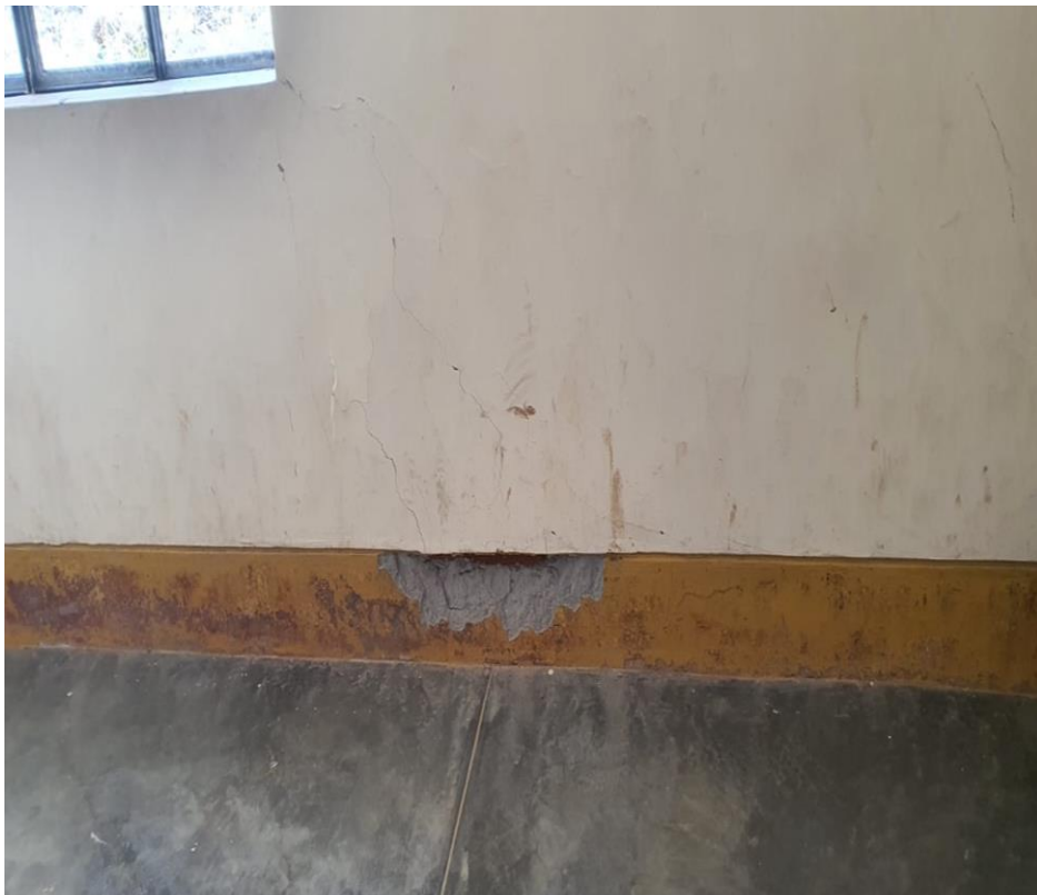
FOTO N°6 SE OBSERVA LA PINTURA EN MAL ESTADO EN LOS MUROS INTERIORES
