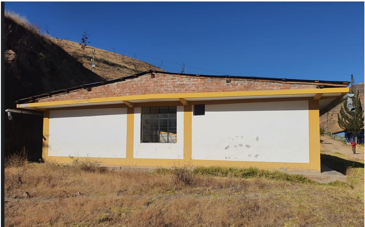
FOTO N°2 FACHADA TRASERA, SE OBSERVA PINTURA EN MAL ESTADO EN LA FACHADA DEL PUESTO DE SALUD
