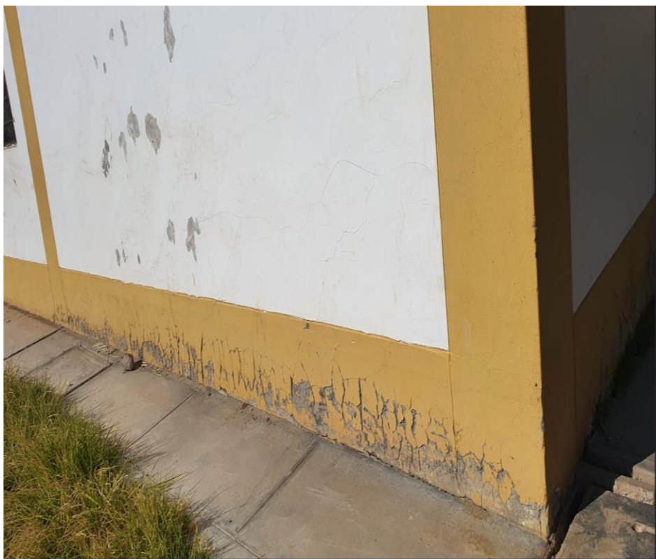
FOTO N°3 SE OBSERVA PINTURA EN MAL ESTADO EN LA FACHADA DEL PUESTO DE SALUD
