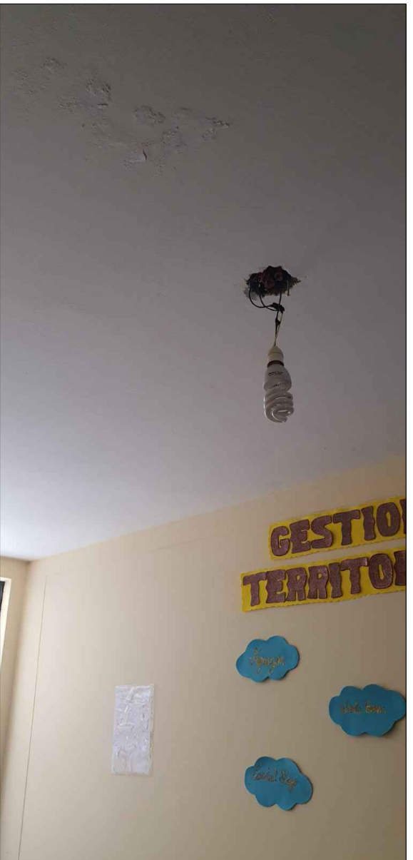
IMAGEN N°2Y3 : SE VISUALIZA FOCOS EXTERIORES QUE NO FUNCIONAN COMO TAMBIEN FOCOS COLGADOS EN MAL ESTADO
