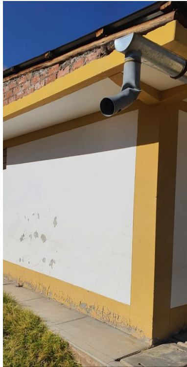
FOTO N°5 SE OBSERVA LA CANALETA EN MAL ESTADO
