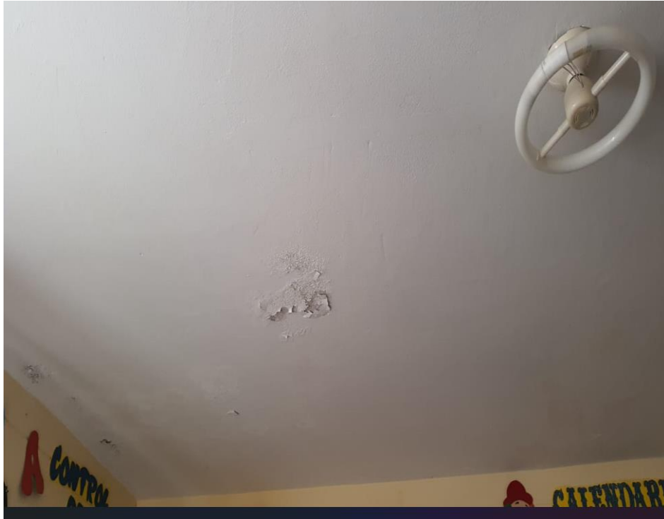
FOTO N°7 SE OBSERVA LA PINTURA EN MAL ESTADO DEL TECHO POR LAS LLUVIAS
