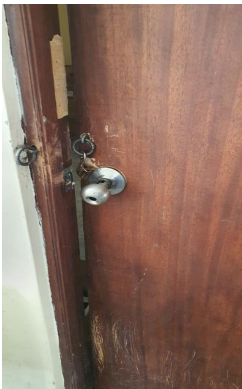
FOTO N°18 SE OBSERVA LAS CHAPAS DE LAS PUERTAS EN MAL ESTADO
