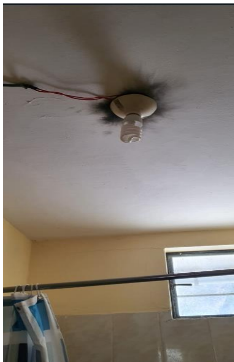
FOTO N°14 SE OBSERVA CONEXIONES ELECTRICAS EN MAL ESTADO
