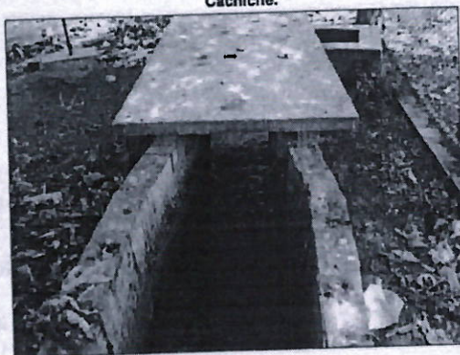
Foto 4. Primer medidor de caudal de la Planta de Tratamiento de Aguas Residuales de Cachiche.
