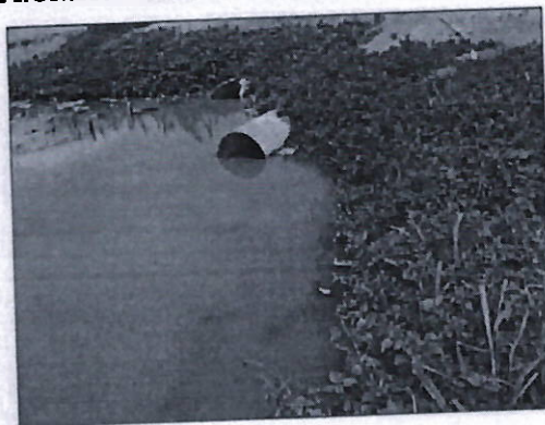
FOTO 9. CONDUCTOS DE EVACUACIÓN FINAL DE LA PTAR CACHICHE.
