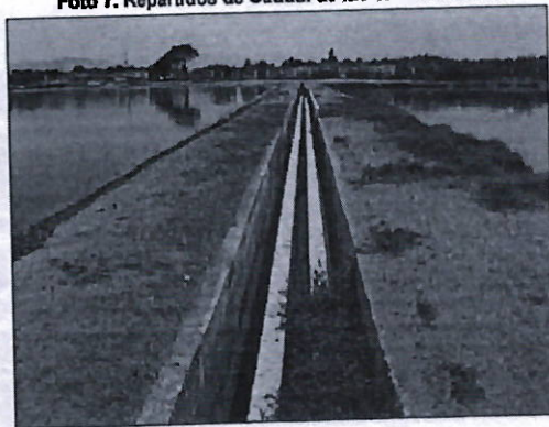
Foto 7. Repartidos de Caudal de la PTAR Cachicho.
