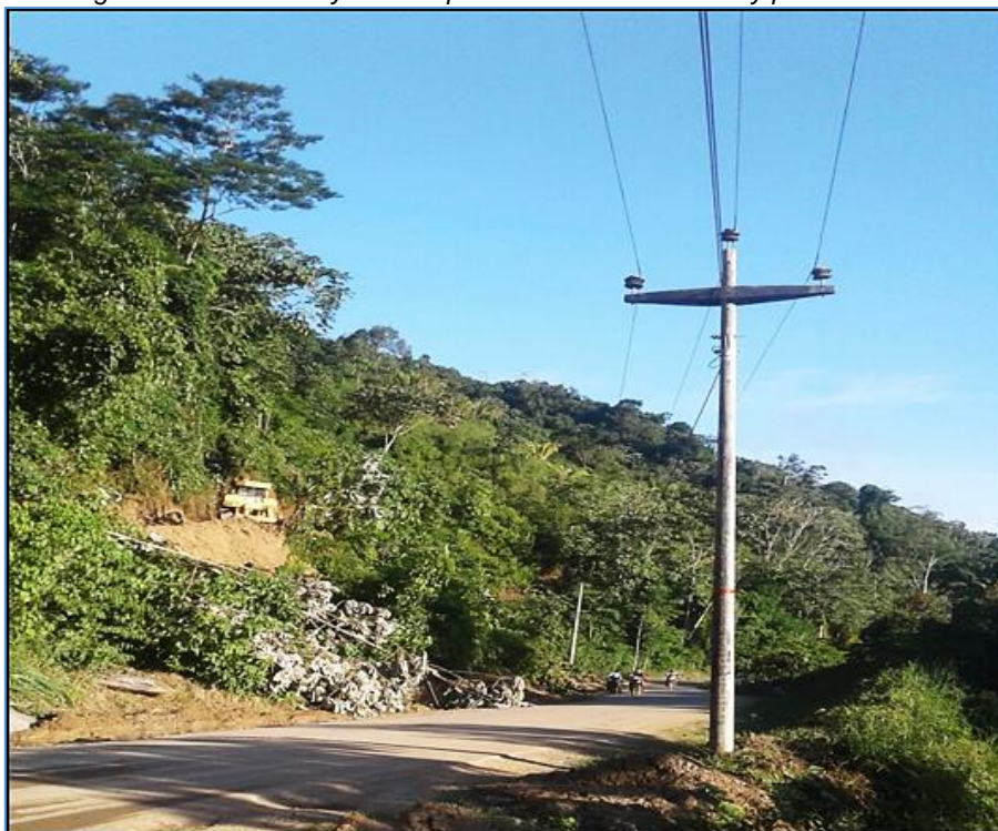
Fig. 2. Postes de LP y RP con presencia de crucetas muy pesadas
