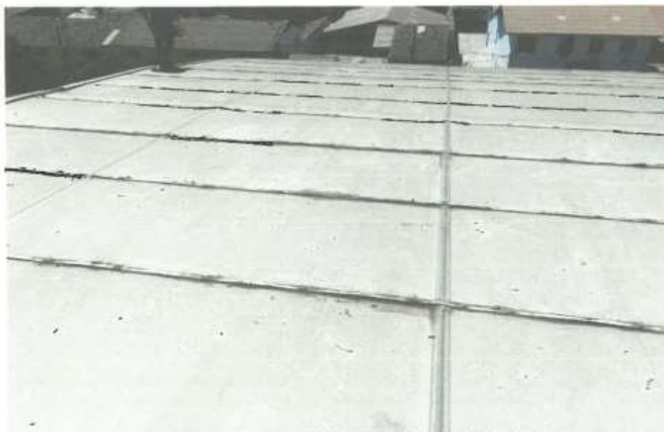
Imagen 02: vista superior de la cobertura policarbonato alveolar deteriorado del coliseo
