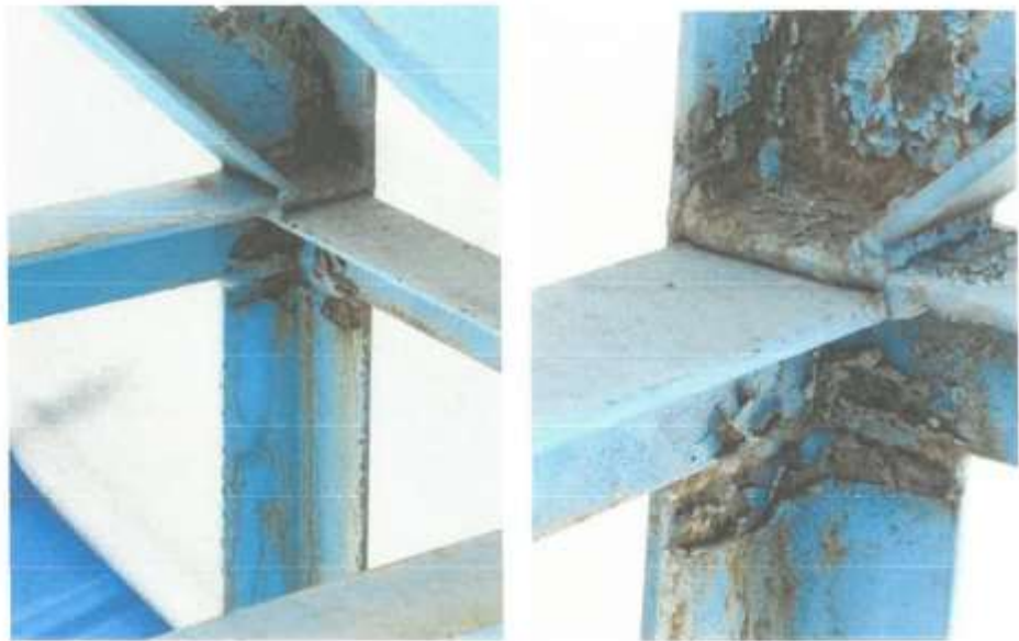
Imagen 09: Estructura metálica deteriorada – vista de vigas armadas oxidada
