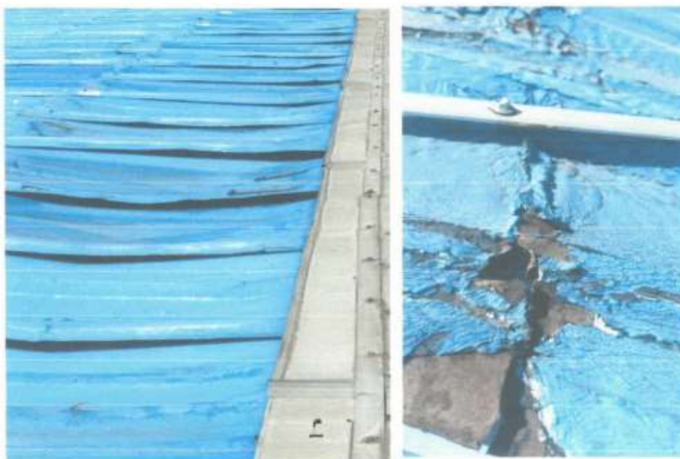
Imagen 04: vista superior de la cobertura termoacústico deteriorado del coliseo
