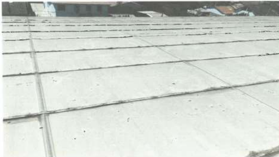
Imagen 01: vista superior de la cobertura policarbonato alveolar deteriorado del coliseo
