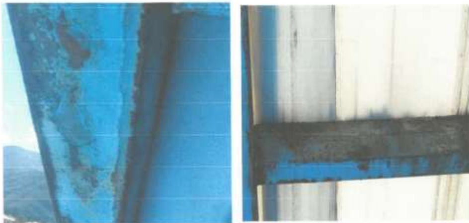
Imagen 07: Estructura metálica deteriorada – vista de correas metálicas oxidada
