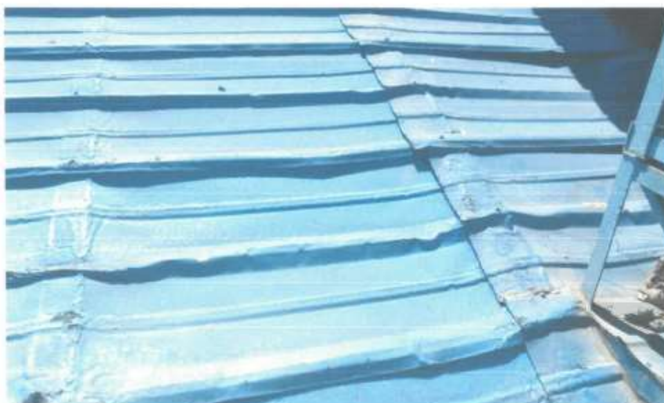
Imagen 06: vista superior de la cobertura termoacústico deteriorado del coliseo
