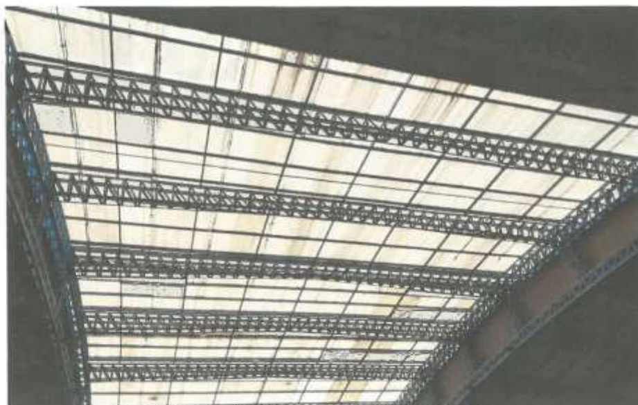
Imagen 03: vista inferior de la cobertura policarbonato alveolar deteriorado del coliseo
