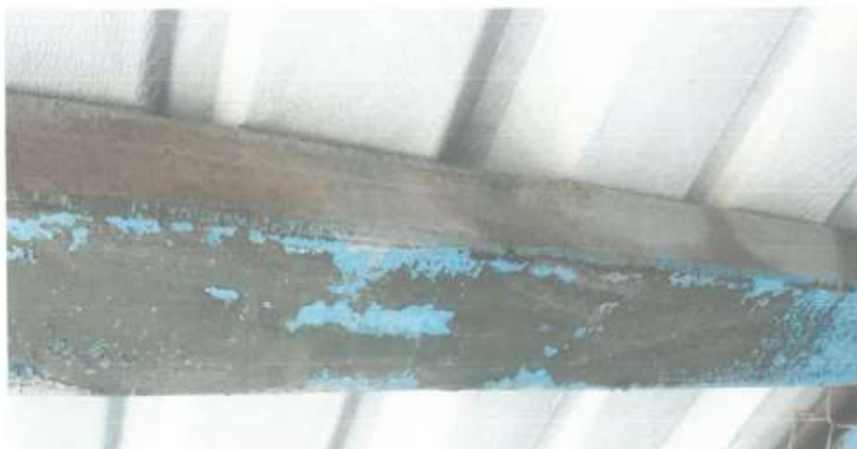
Imagen 08: Estructura metálica deteriorada – vista de correas metálicas oxidada
