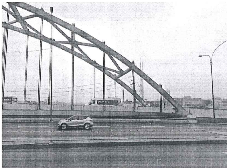
Imagen 03.- Viga tipo arco, arriostres, tensores y tijerales del puente vehicular ejercito
