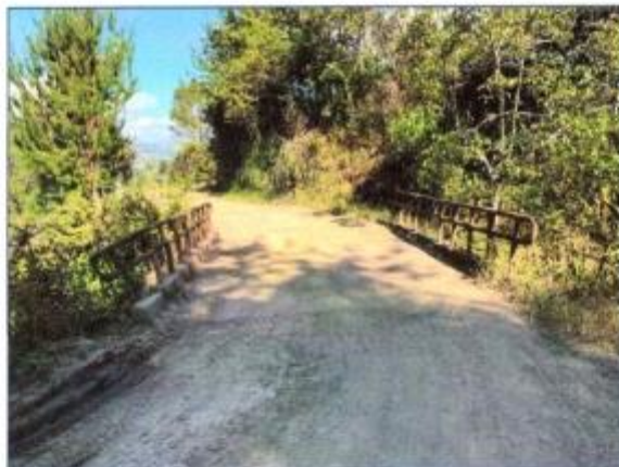
Figura 2: Estado actual de la losa, no tiene veredas y barandas de seguridad en mal estado
