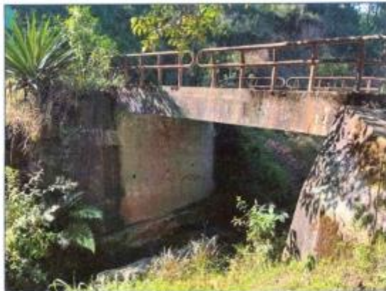
Figura 2: Estado actual de la losa, no tiene veredas y barandas de seguridad en mal estado
