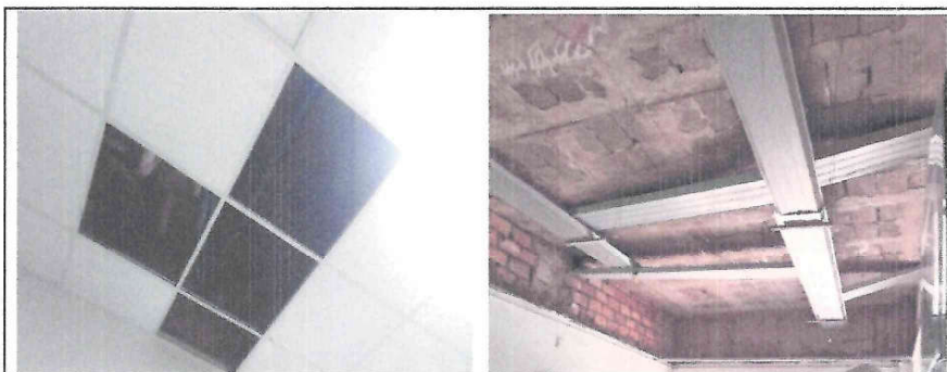
Fotos 05 y 06: filtraciones pluviales registradas en vestuarios de Enfermeras - CQ, y la intervencion con canalizacion de goteras.
