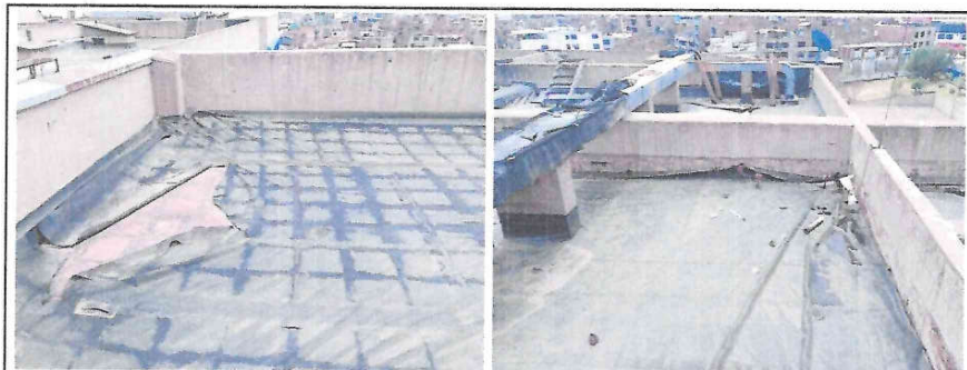
Fotos 01 y 02: Se observa que la geomembrana ha perdido adherencia sobre la cobertura, dejando sin protección al servicio de Centro Quirúrgico en épocas de lluvia.
