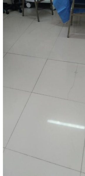
PISO DE PORCELANATO FISURADO Y DESPRENDIDO EN SALA DE RECUPERACION
