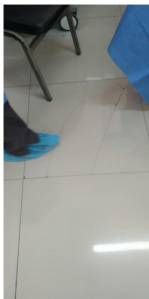
PISO DE PORCELANATO FISURADO Y DESPRENDIDO EN SALA DE RECUPERACION
