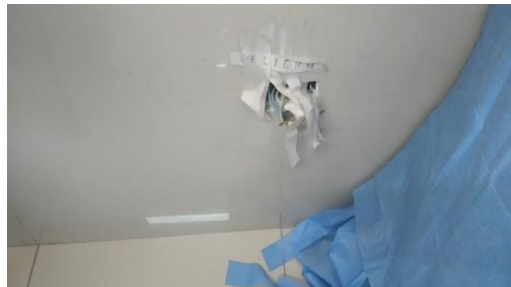
TOMACORRIENTES DETERIORADOS
