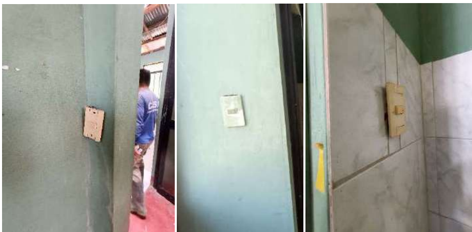
Imagen 45: interruptores desprendidos de sus cajas de paso
