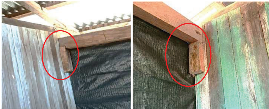
Imagen 08 y 09: Apoyos de viga sobre dados (tacos) de madera
