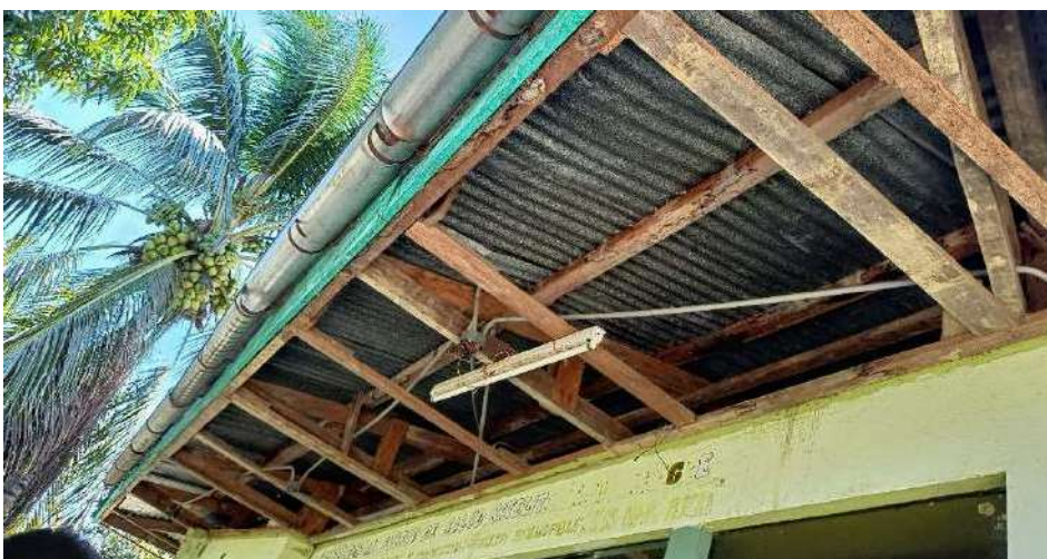
Imagen 39: canalizaciones con tuberías PVC cristalizadas y sin aseguramiento, mismo que también luminaria inoperativa en exteriores (lado frontal del local).
