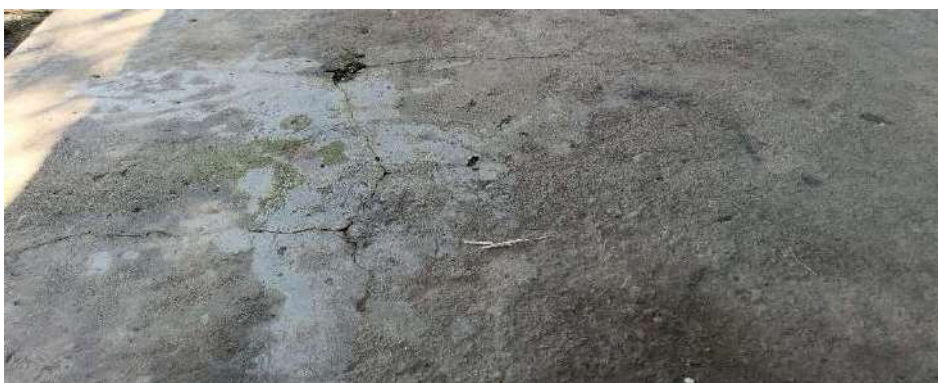
Imagen 21: vereda en la parte frontal presenta rajaduras y desgaste de la superficie pulida.
