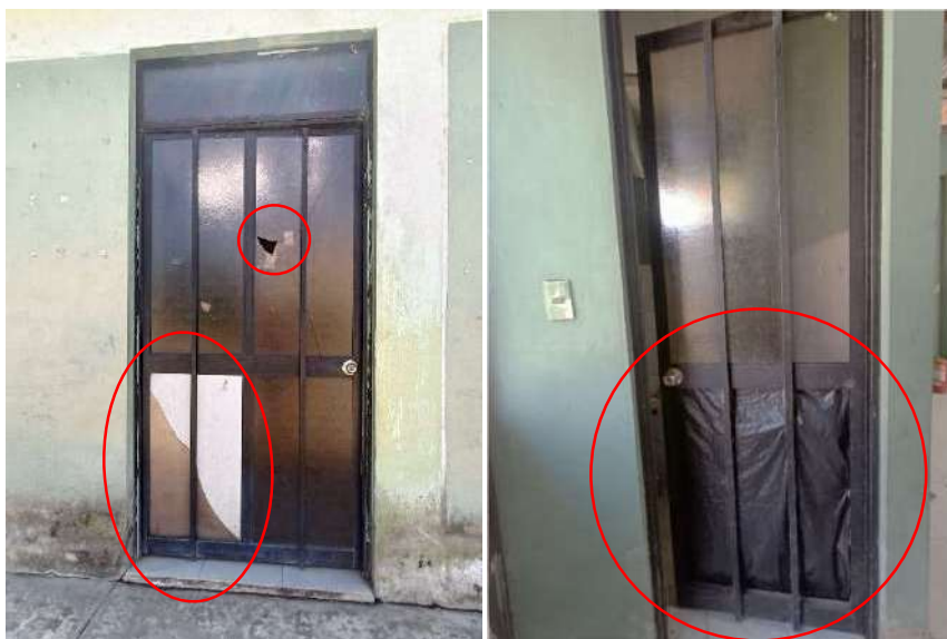
Imagen 27 e imagen 28: vidrios rotos y cerraduras malograda en puertas una hoja imagen izquierda puerta de ingreso secundario al botiquín e imagen derecha puerta de ingreso a SSHH del área de sala de espera)
