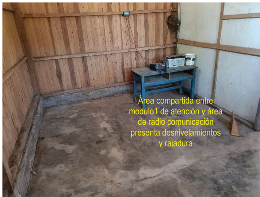
Imagen 11: Falso piso en área compartida: modulo 1 de atención y área de radio comunicación
