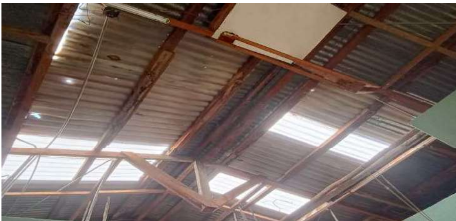
Imagen 02: Calaminas traslucidas se encuentran cristalizadas y rotas
