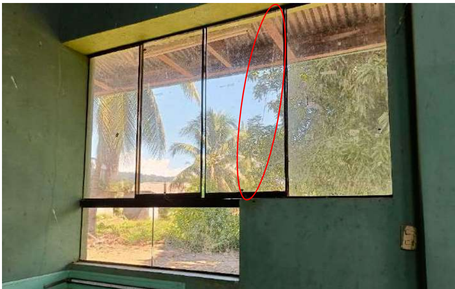
imagen 29: Ventana del de la parte frontal se encuentra fracturada
