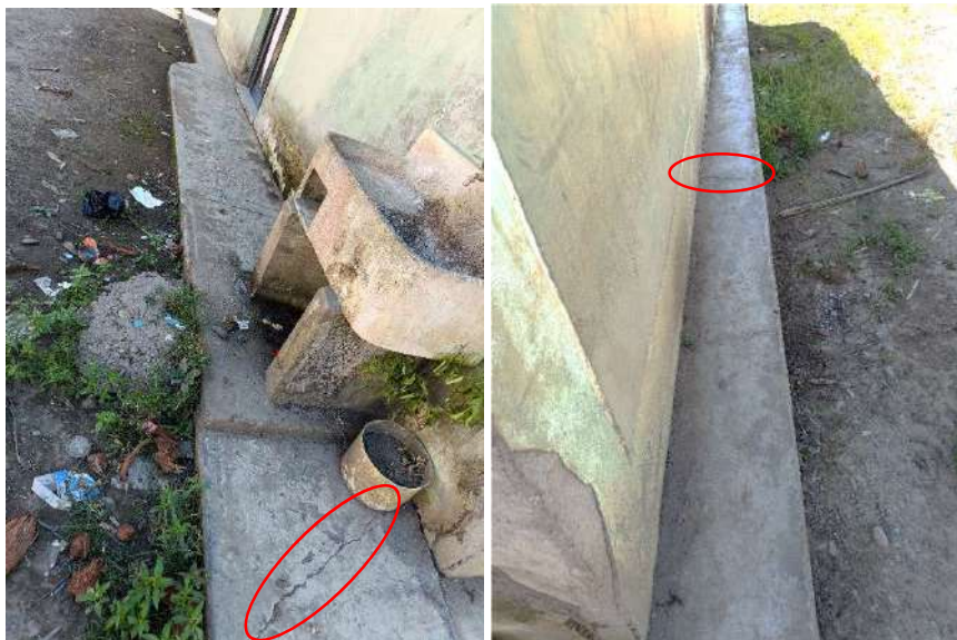
Imagen 24 (derecha): vereda lado posterior presenta desgaste de superficie y erosión en la base
