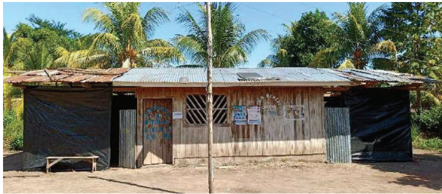
Imagen 06: Muros de madera y rafia en el botiquín comunal (vista de la parte frontal)
