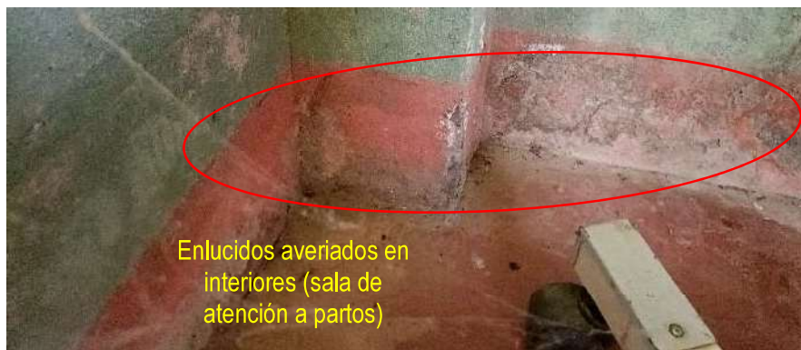
Imagen 13: enlucidos averiados en sala de atención a partos.
