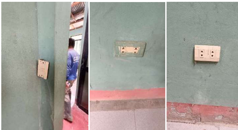
Imagen 46 y 47: interruptores y tomacorriente desprendidos de sus cajas de paso rectangular.
