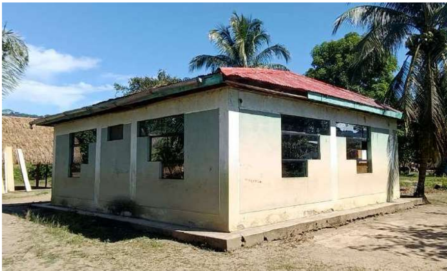
Imagen 36: lado exterior lateral derecho y posterior se aprecia a los muros, columnas, contra zócalos y vigas con pinturas blanqueadas, manchadas y desgastadas.
