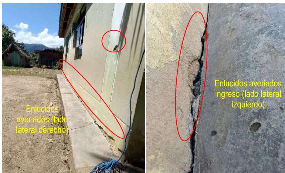
Imagen 09 (izquierdo): enlucidos averiados en exteriores lado lateral derecha Imagen 10 (derecha): enlucidos averiados en exteriores lado lateral izquierdo.
