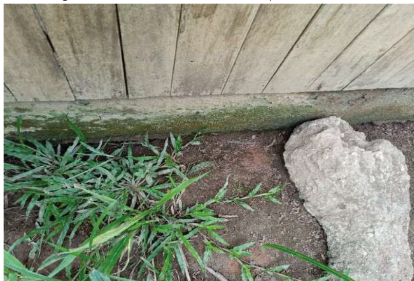
Imagen 15: Daño a muros en exteriores por falta de veredas
