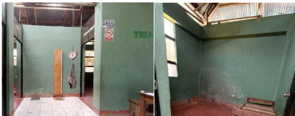
Imagen 37 y 38: en interiores se aprecia a los muros, columnas, contra zócalos y vigas con pinturas blanqueadas y manchadas.
