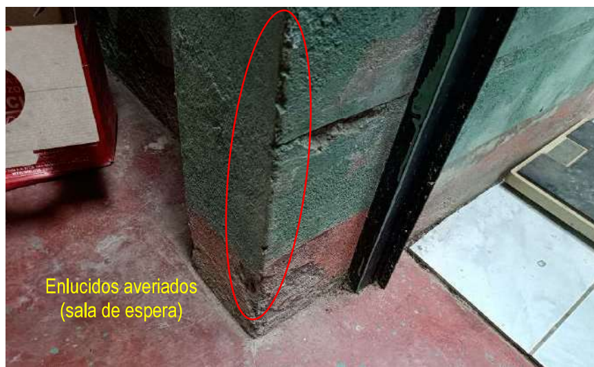
Imagen 12: enlucidos averiados en interiores área sala de espera.
