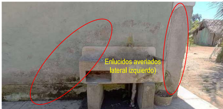
Imagen 12: enlucidos averiados en interiores área sala de espera.
