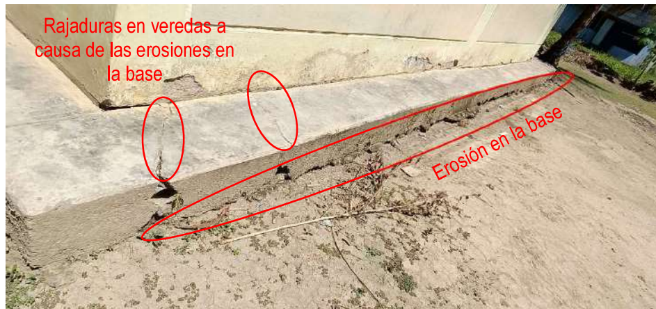
Imagen 22: vereda en el parte lateral derecho presenta rajaduras y erosión en la base
