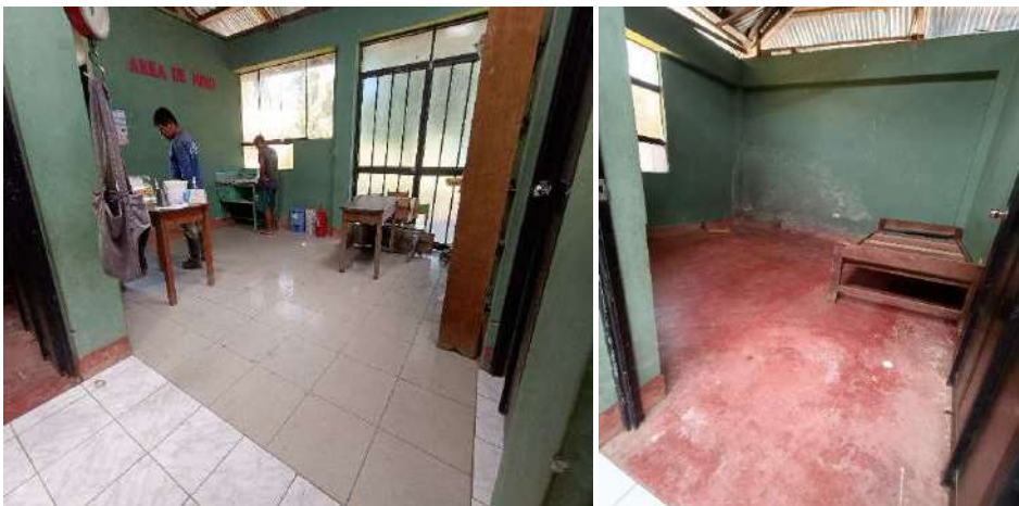
Imagen 19 (izquierdo): piso de cerámicos área de sala de espera en buenas condiciones Imagen 20 (derecha): piso pulido con manchas blancas en área de alojamiento.
