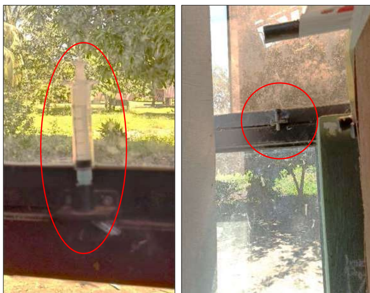
Imagen 30 y 31: ventanas corredizas se encuentran sin seguros pistillos o parte de los mismos accesorios
