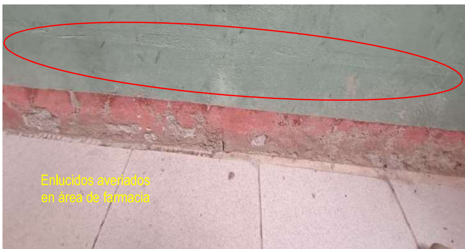
Imagen 16: enlucidos averiados en interiores área de farmacia.
