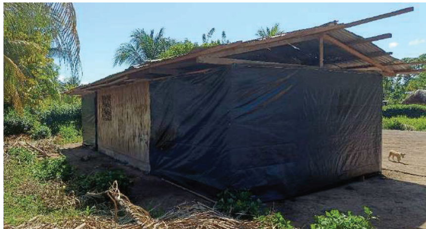
Imagen 07: Muros de madera y rafia en el botiquín comunal (vista de parte posterior)
