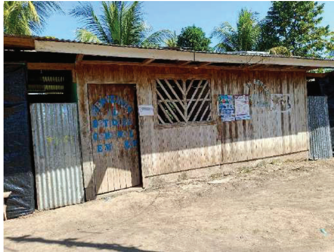
Imagen 20: El local no cuenta con ningún tipo de pintura como protección
