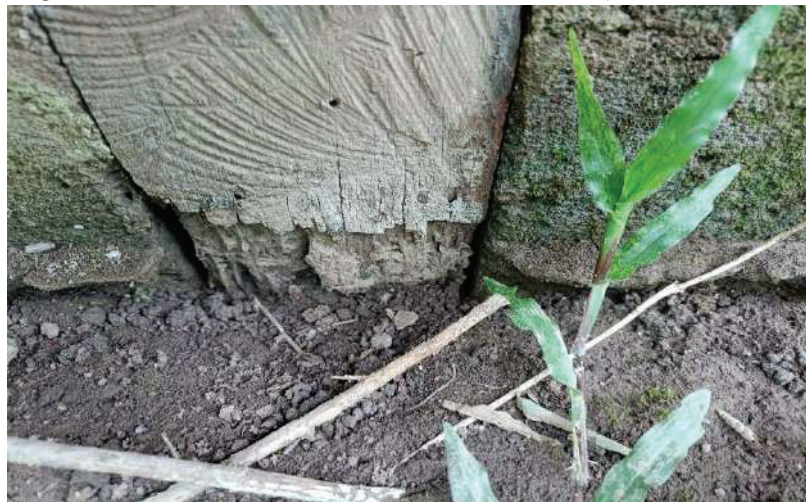
Imagen 14: Daño a columnas de madera en exteriores por falta de veredas
