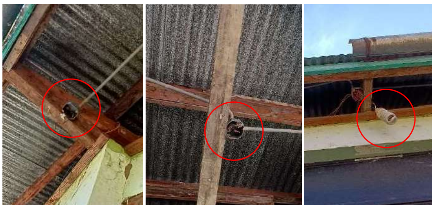
Imagen 42, 43 y 44: puntos de luz sin luminaria y luminarias inoperativas en exteriores e interiores .
