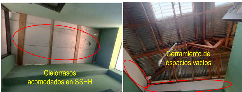
Imagen 05 (izquierdo): Cielorraso acomodados en SSHH provisionalmente por usuarios; Imagen 06 (derecho): cerramiento de espacios vacío entre techo y muro para evitar el ingreso de animales silvestres.
