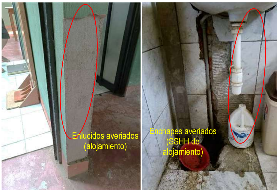
Imagen 14 (izquierdo): enlucidos averiados en interiores área de alojamiento Imagen 15 (derecha): enchapes averiados en SSHH del área de alojamiento.
