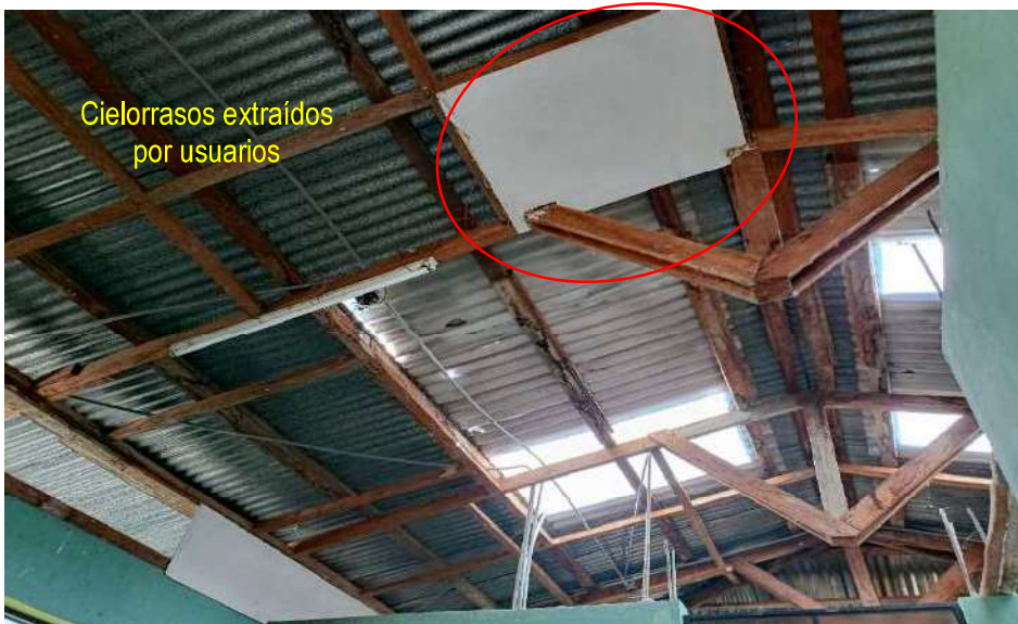
Imagen 04: Cielo raso en interior y exterior fueron desmontados para evitar la vivencia de murciélagos.
