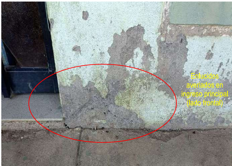
Imagen 08: enlucidos averiados en exteriores parte frontal del local.
