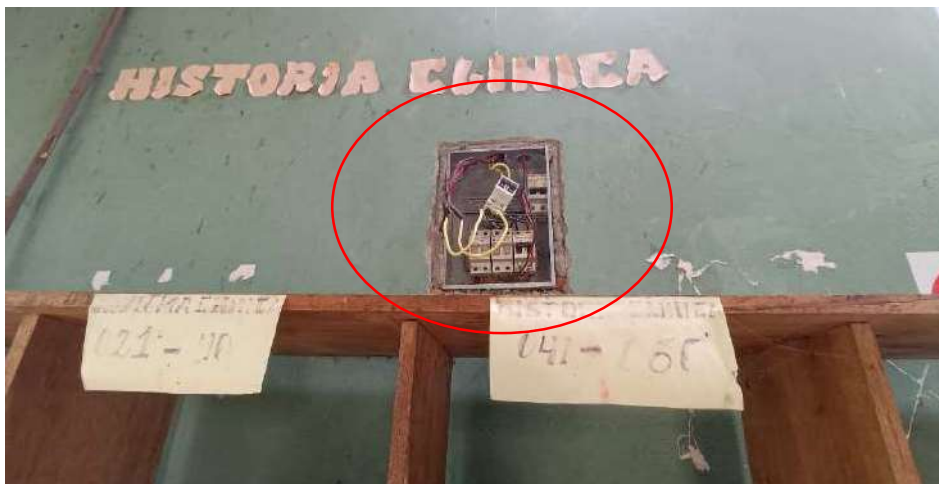
Imagen 48: tablero de distribución sin tapa y 5 llaves termomagnéticas sin buen aseguramiento para la falta de riel en el tablero.
