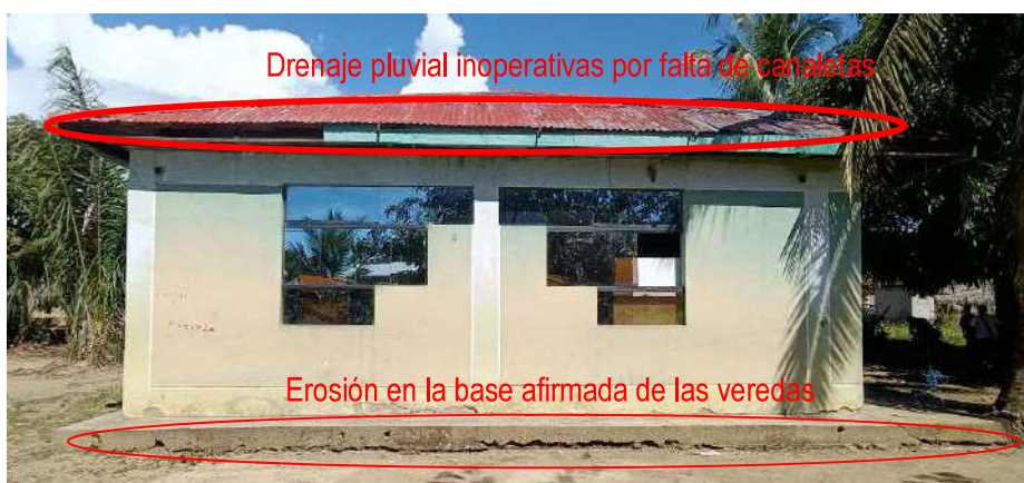
Imagen 07: Drenaje pluvial inoperativas por la falta de canaletas y accesorios de sujeción
