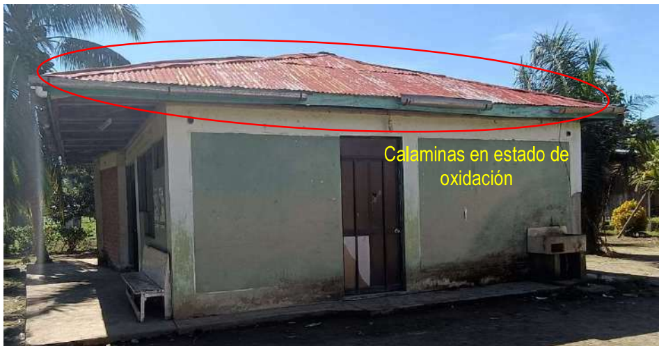
Imagen 01: Calaminas en estado de oxidación
