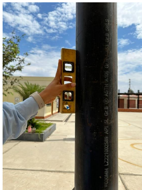
Fotografías de la verificación de alineación de columnas Insitu
