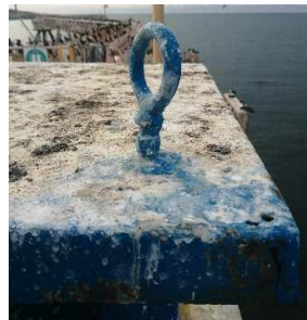
Figura 6. Ojales de techo para izaje
