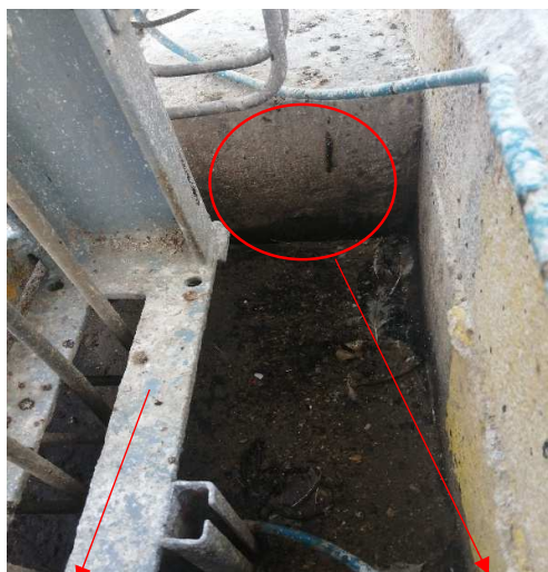
Soporte antiguo de válvula distribuidora que se va a retirar
