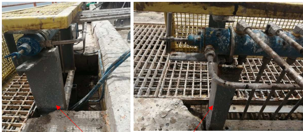
Figura 10. Vistas de soporte actual de válvula distribuidora a pie de brazo
