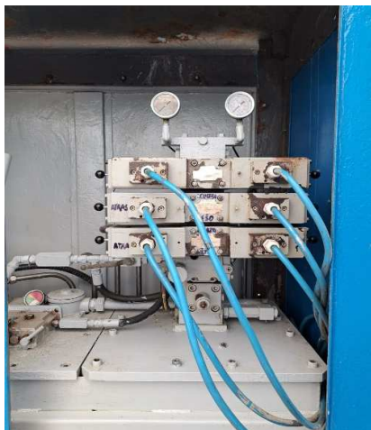
Figura 9. Referencia 06 cables alimentación 24Vdc control electroválvulas direccionales
