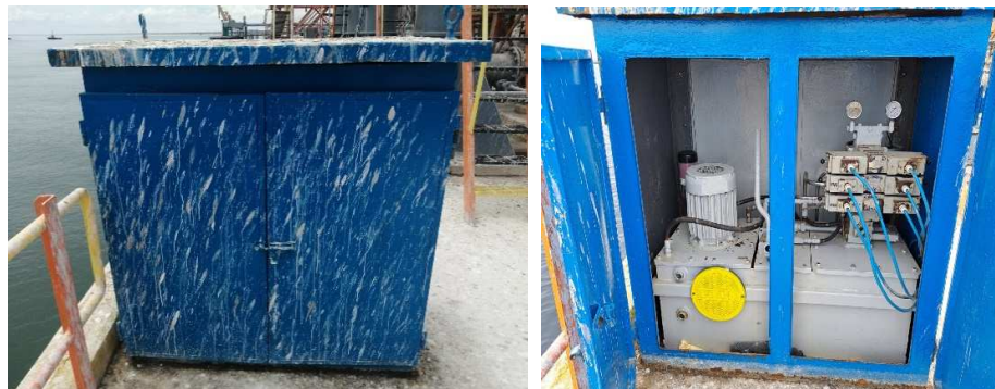
Figura 7. Vista de cubículo de central hidráulica
