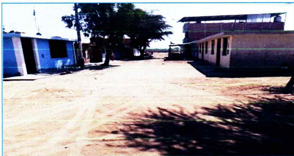
FOTO N° 10.- Vista de calle Humberto La Torre donde se observa baches y ahuellamientos pronunciados y las veredas de concreto sin asistencia técnica adecuada.
