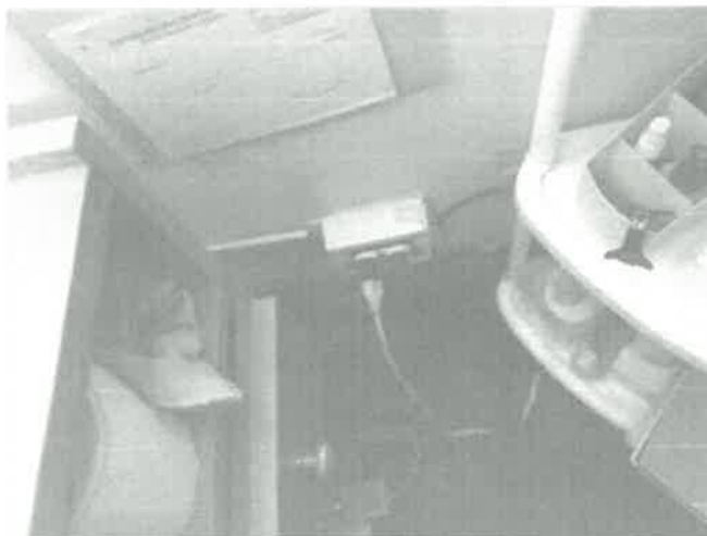
TOMACORRIENTES EN MAL ESTADO, REQUIEREN DE CAMBIO.
