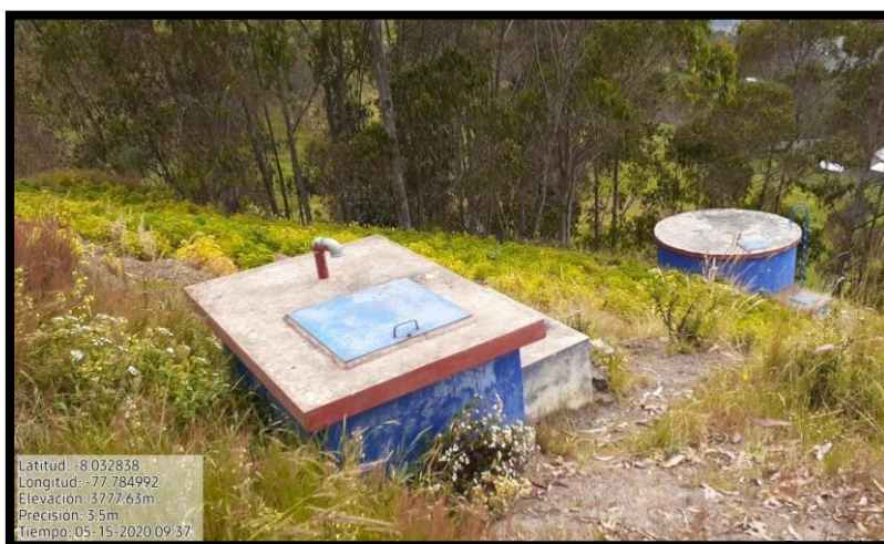
IMAGEN N° 49: En esta imagen se visualiza la Cámara de Distribución en buenas condiciones de conservación,
