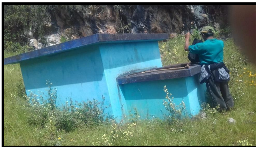
IMAGEN N° 32: Reservorio existente N°06 de 5m 3 en buen estado y esta siendo intervenido por RCC
