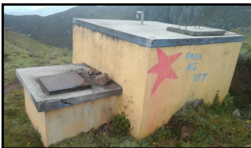
IMAGEN N° 29: Reservorio Existente N°04 de 10m 3 en regular estado de conservación y será intervenido por RCC.
