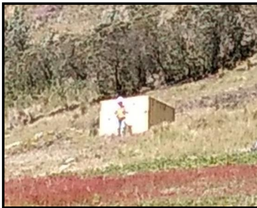
IMAGEN N° 40: Reservorio Existente en regular estado de conservación, cambio de tarrajeo interior y exterior, cambio de accesorios y tapas
