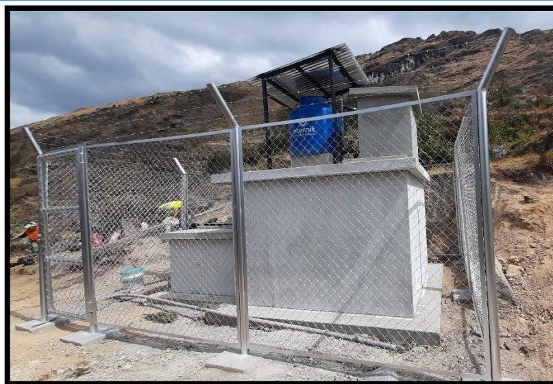
IMAGEN N° 13: Reservoirio en ejecución por RCC N°02 de 5m3
