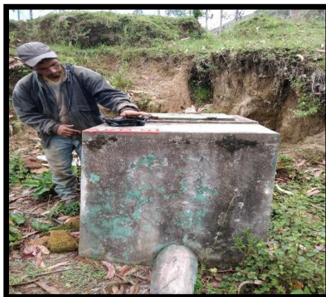
IMAGEN N° 14: CRP TIPO 7 En mal estado tramo 1 y será reemplazada
