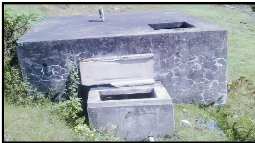
IMAGEN N° 12: Reservoirio Existente Intervenido por RCC N°02 de 5m3
