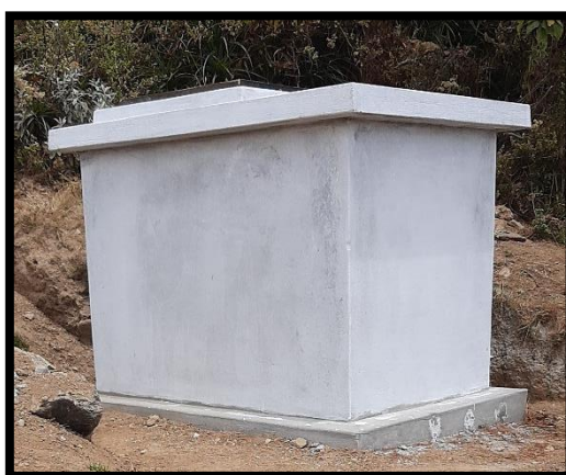
IMAGEN N° 15: CRP TIPO 7 En mal estado tramo 2, intervenido por RCC
