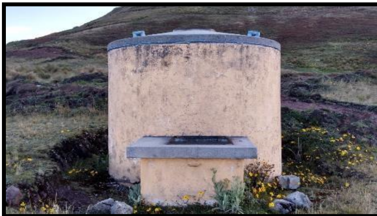
IMAGEN N° 26: Reservorio Existente N° 01 en mal estado, presenta filtraciones la parte inferior de los muros.
