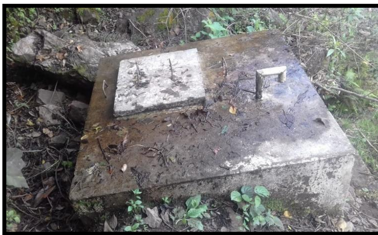
IMAGEN N° 42: CRP T-7 Existente en Mal Estado de conservación
