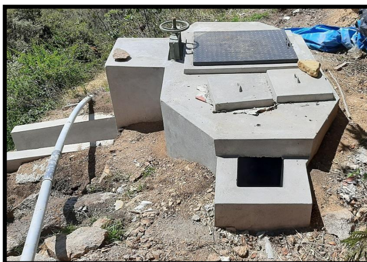
IMAGEN N° 09: Desarenador en Uchucubamba en construcción por RCC – En ejecución
