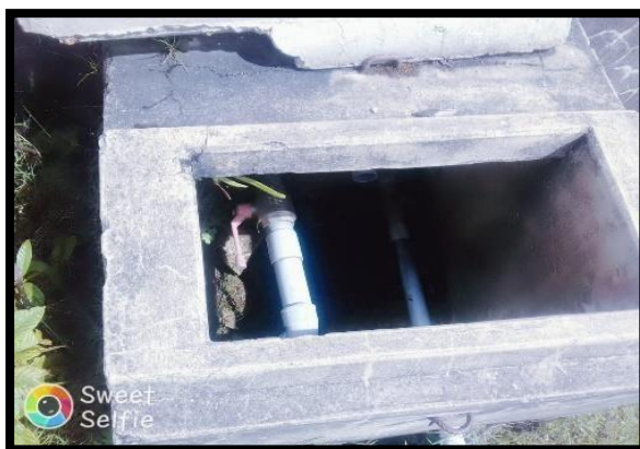
IMAGEN N° 47: Caja de válvulas de Reservorio Existente
