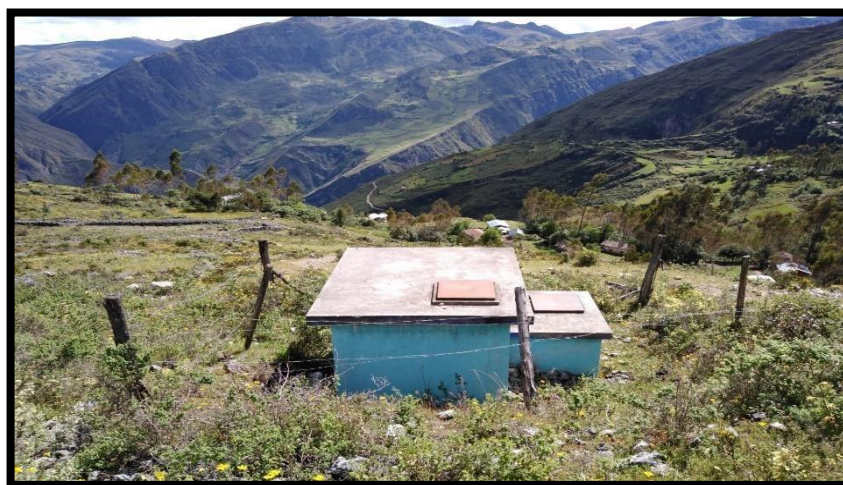
IMAGEN N° 31: Reservorio existente N°05 de 5m 3 en buen estado
