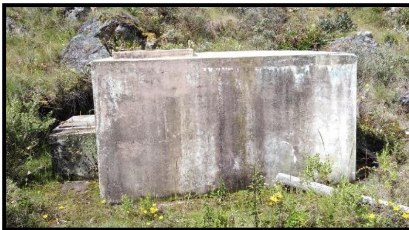
IMAGEN N° 11: Reservorio Existente N°01 de 5m3 en malas condiciones, presenta filtraciones en la estructura.
