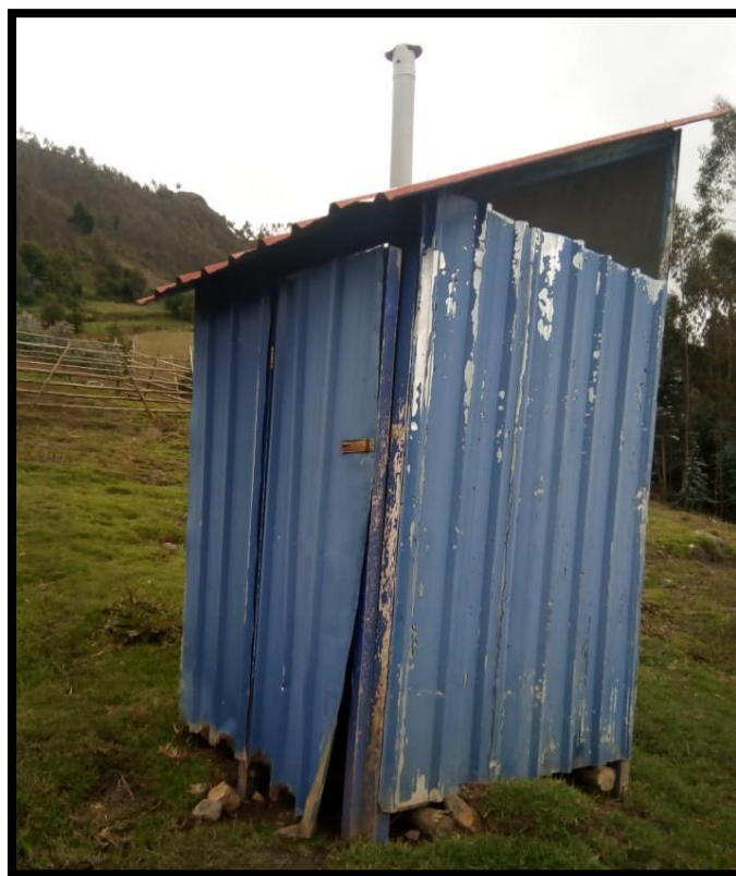
IMAGEN N° 56: Acá se visualiza el estado de conservación de las letrinas con hoyo seco ventilado en la localidad de Chagavara
