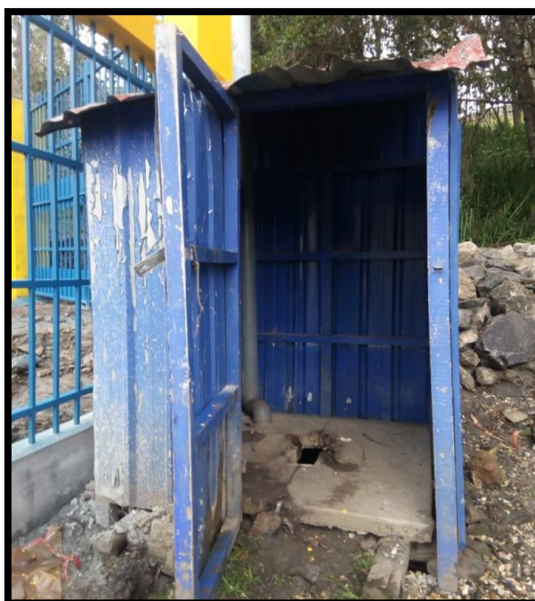
IMAGEN N° 55: Acá se visualiza el estado de conservación de las letrinas con hoyo seco ventilado en la localidad de Chagavara
