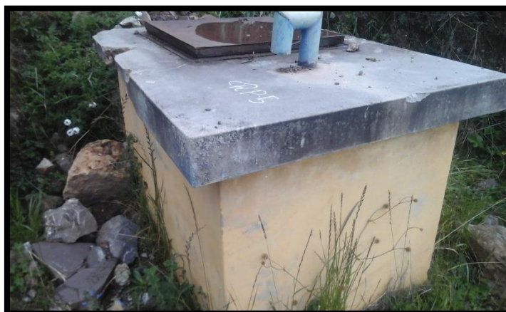
IMAGEN N° 35: CRP T-7 EN MAL ESTADO
