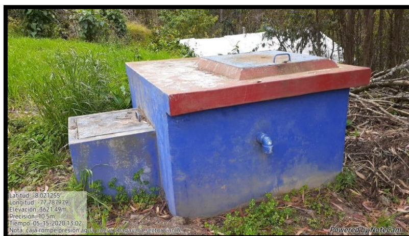
IMAGEN N° 53: En esta imagen se visualiza una de las CRP-7 que se encuentra en buenas condiciones.
