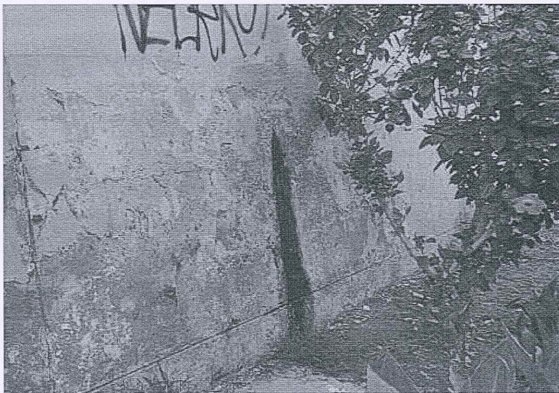
IMAGEN 19: Mantenimiento de filtraciones en muro
