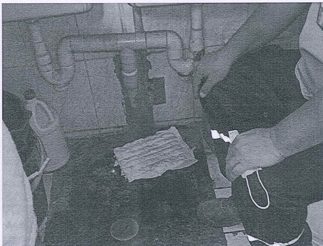
IMAGEN 23: Mantenimiento de trampas y sumideros
