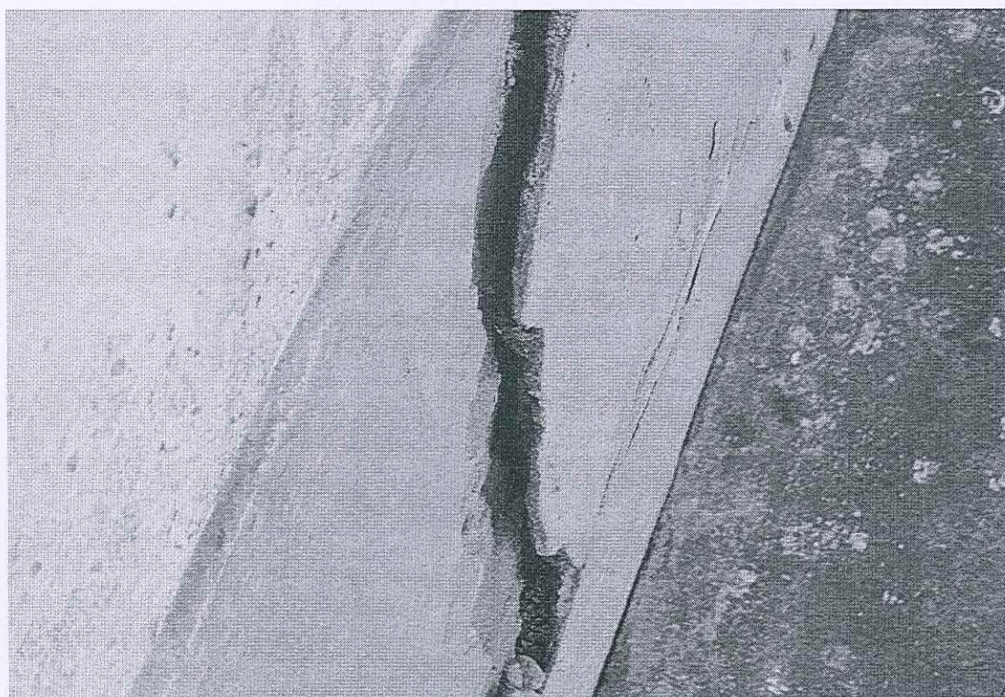
IMAGEN 16: Resane de muros
