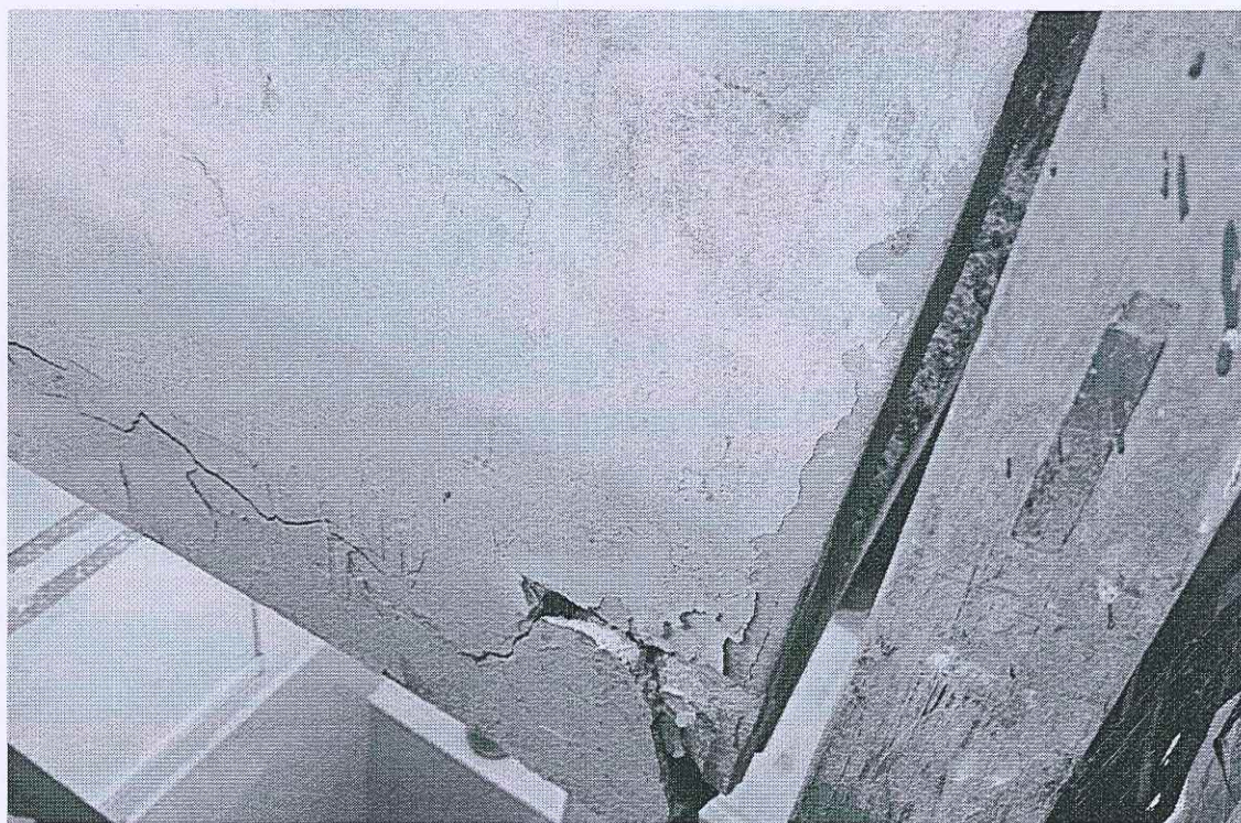
IMAGEN 18: Resane de muros
