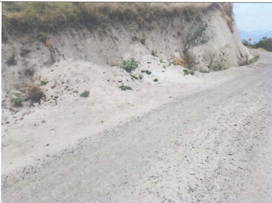
PROGRESIVA: 15+325 - 15+405. Cuneta obstruida por material de derrumbe.
