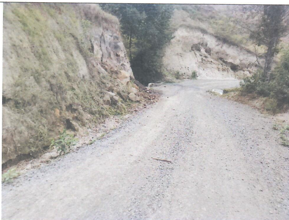
PROGRESIVA: 10+423. Cuneta obstruida por maleza.
