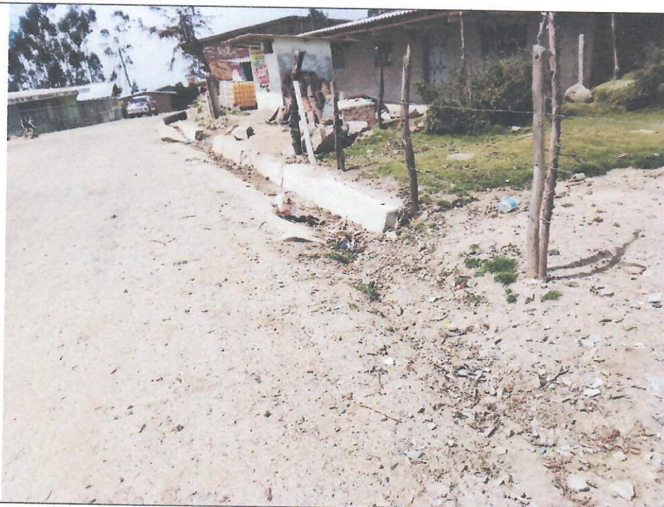
PROGRESIVA: 16+730 - 16+765. Cuneta obstruida por maleza y material propio.
