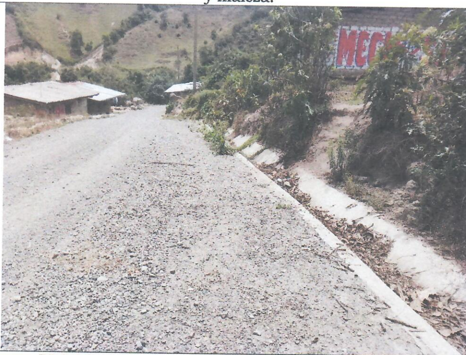
PROGRESIVA: 8+381. Cuneta obstruida por maleza.
