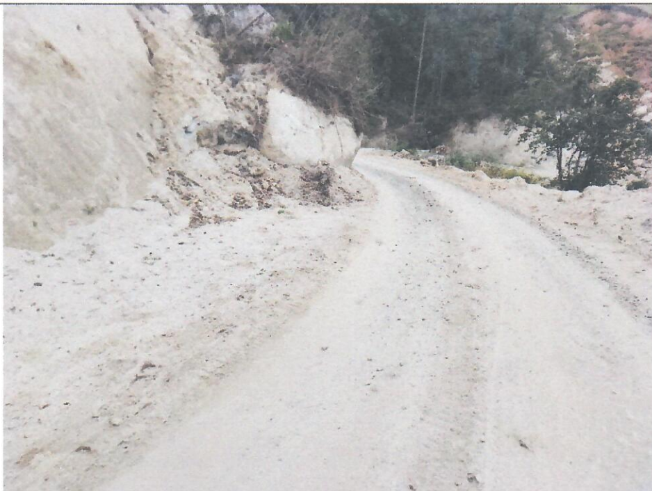
PROGRESIVA: 4+530 - 4+540. Obstrucción de cuneta por material de derrumbe y malezas.
