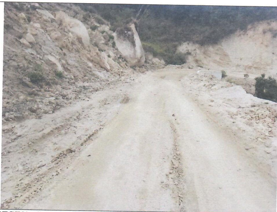
PROGRESIVA: 9+560 - 9+570. Cuneta obstruida por material de derrumbre.
