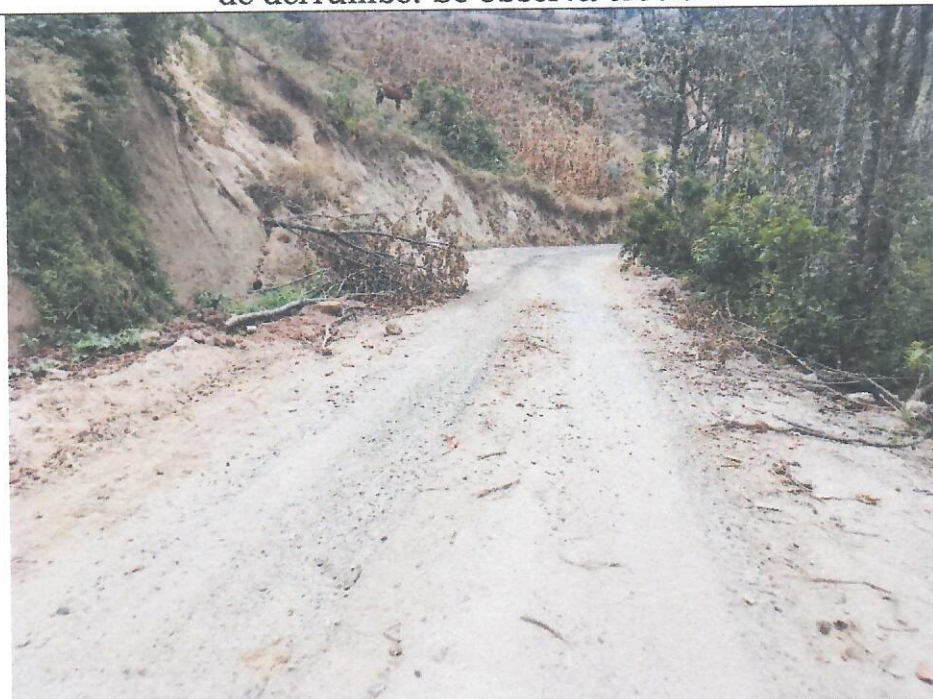
PROGRESIVA: 3+700-4+100. Cuneta obstruida por material de derrumbe y malezas.
