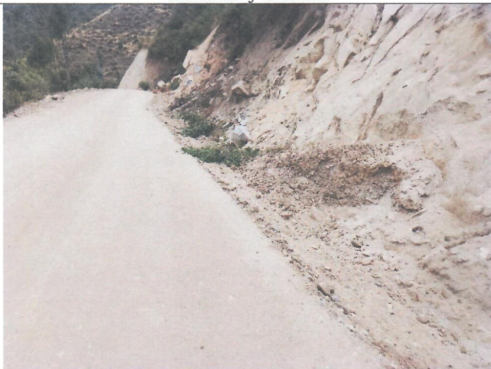
PROGRESIVA: 4+554. Obstrucción de cuneta por material de derrumbe y malezas.
