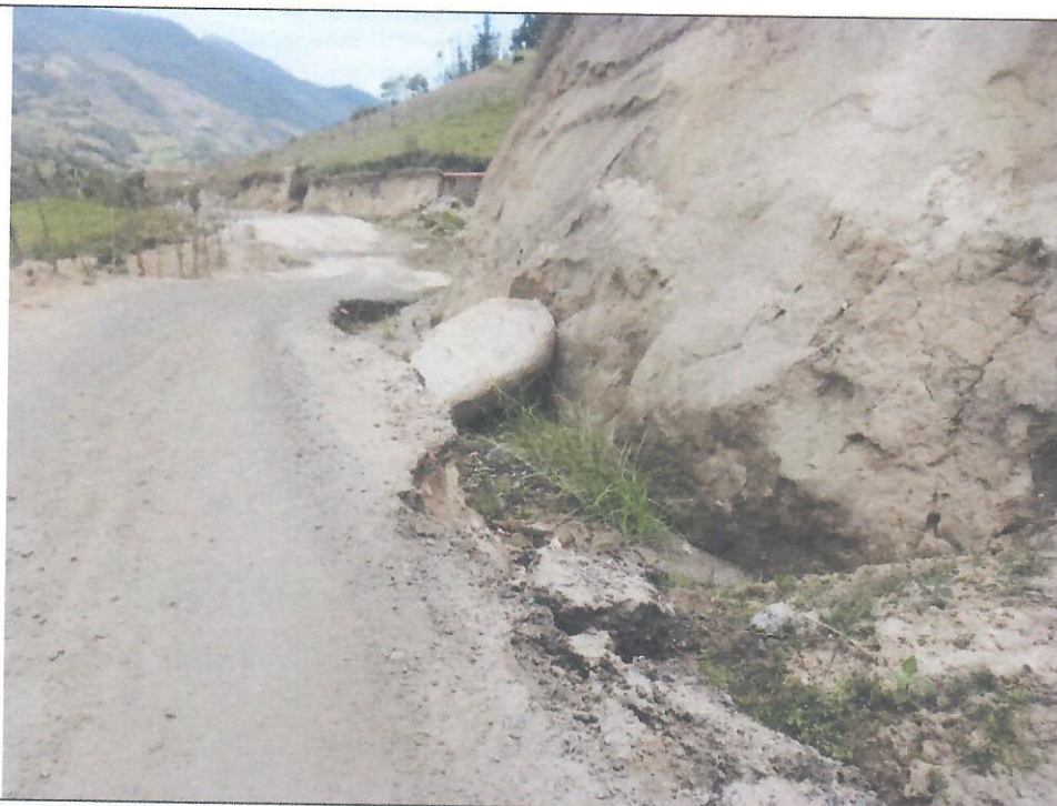
PROGRESIVA: 7+930 - 8+230. Cuneta obstruida por material de derrumbre y maleza.
