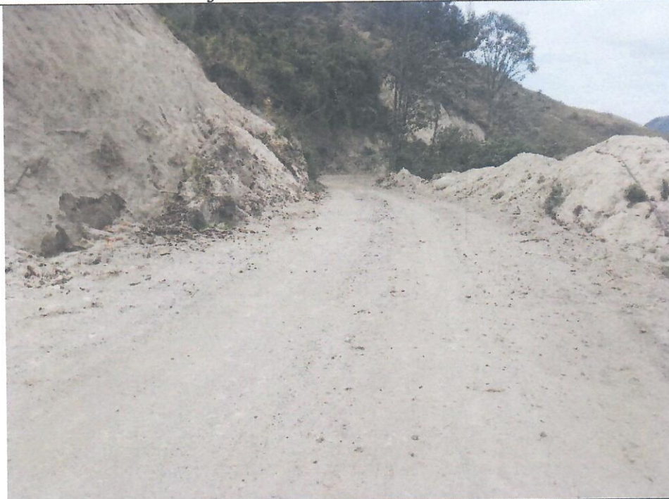
PROGRESIVA: 10+700 - 10+720. Cuneta obstruida por material propio.
