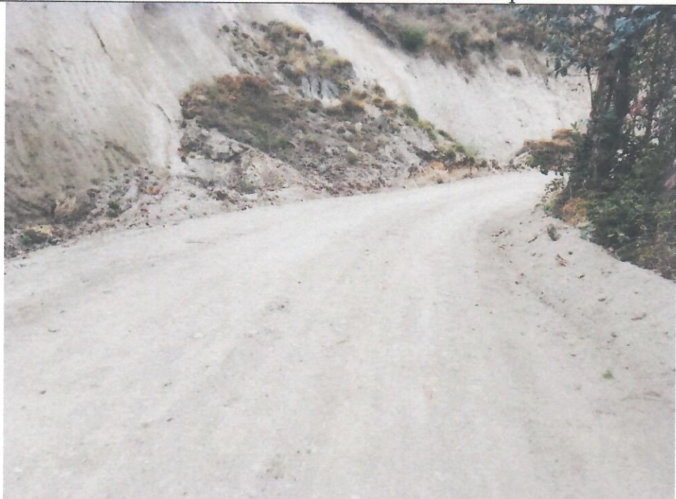
PROGRESIVA: 10+540 - 10+605. Cuneta obstruida por material de derrumbe y maleza.
