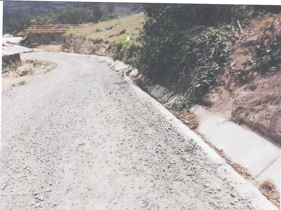
PROGRESIVA: 11+720 - 12+220. Cuneta obstruida por maleza y colmatación.
