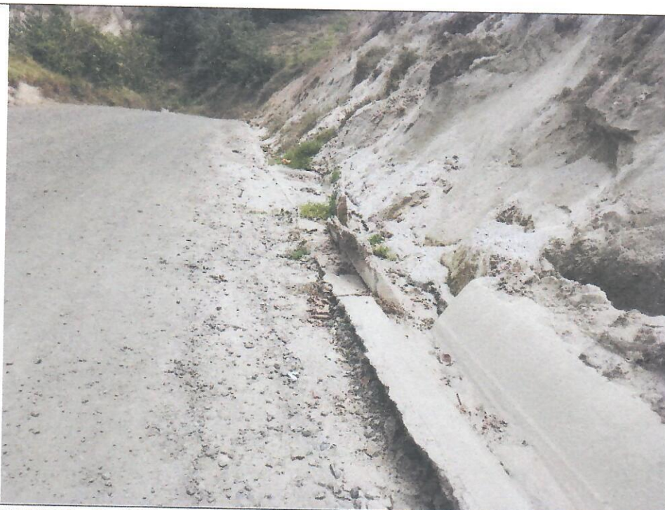
PROGRESIVA: 9+030 - 9+090. Cuneta erosionada y obstruida por maleza y material de derrumbre.
