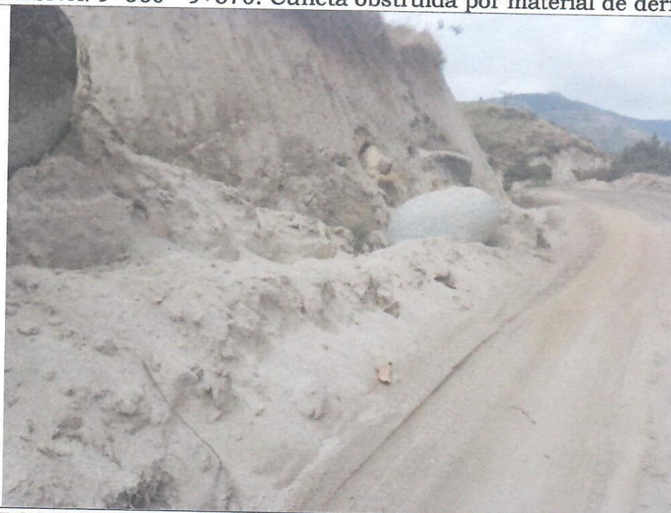
PROGRESIVA: 9+910 - 10+410. Cuneta obstruida por material de derrumbre.
