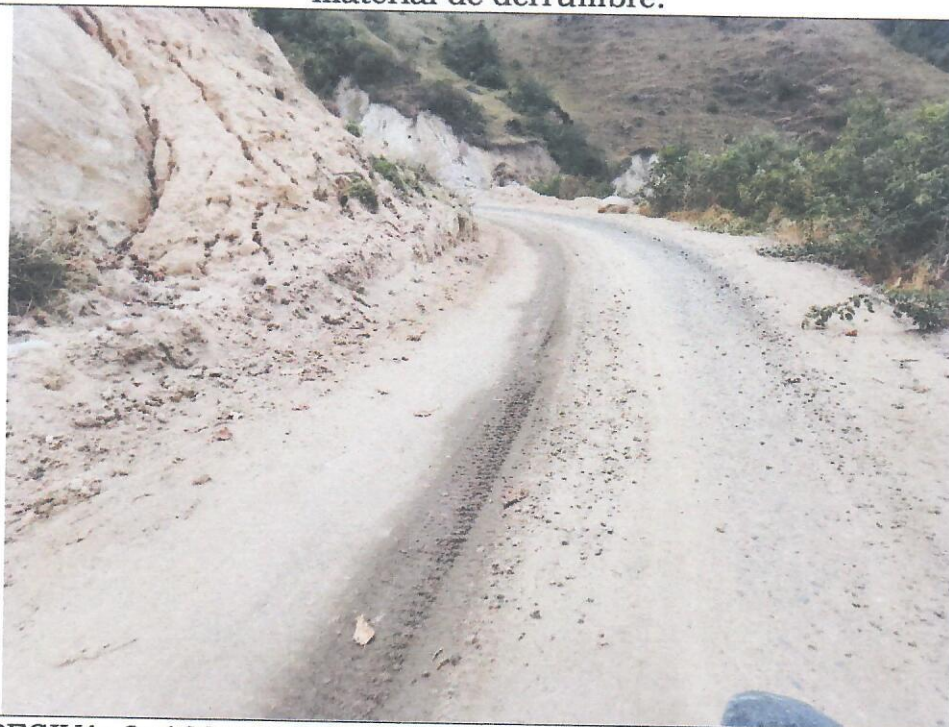
PROGRESIVA: 9+180 - 9+205. Cuneta obstruida por material de derrumbre.
