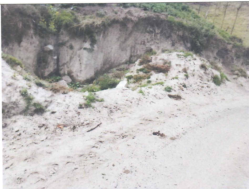
PROGRESIVA: 3+470-3+485. Cuneta obstruida por colmatación y material de derrumbe. Se observa erosión.
