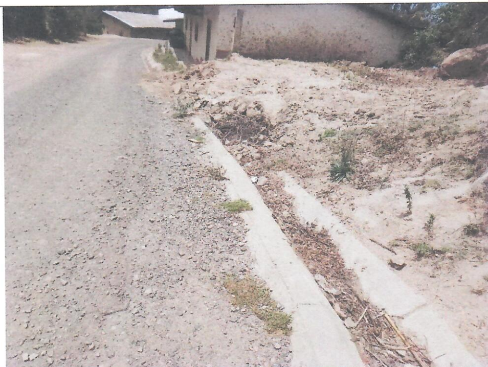
PROGRESIVA: 6+210. Cuneta obstruida por colmatación, maleza y material propio.
