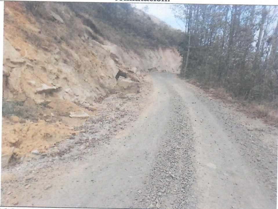
PROGRESIVA: 12+995 - 13+055. Cuneta obstruida por material de derrumbe.
