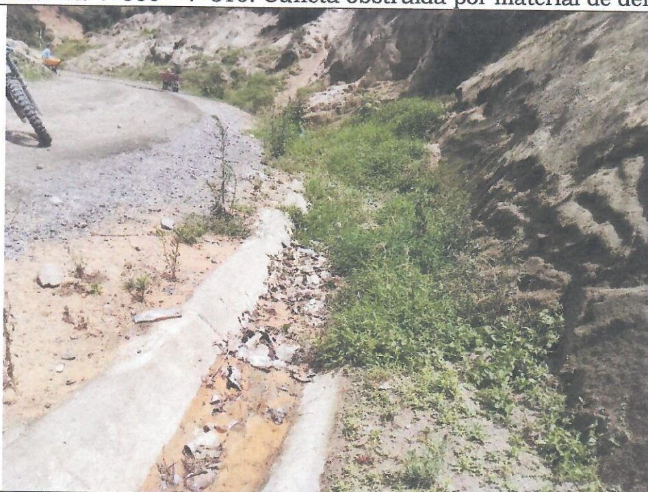
PROGRESIVA: 5+760 - 6+360. Cuneta obstruida debido a colmatación.
