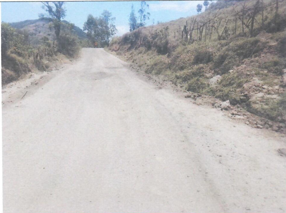
PROGRESIVA: 9+280 - 9+290. Cuneta obstruida por material de derrumbre y colmatación.
