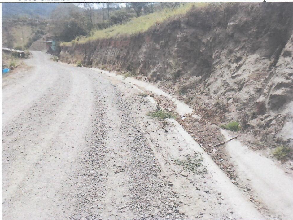
PROGRESIVA: 16+670. Cuneta obstruida por material de derrumbe.
