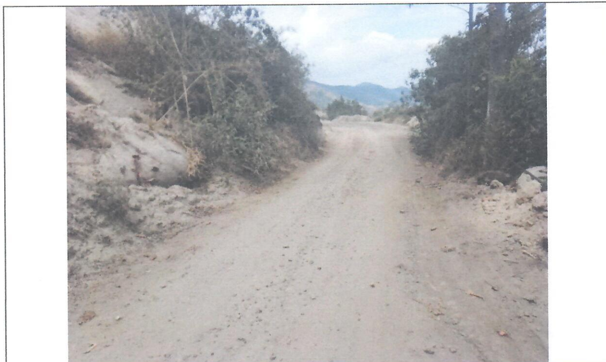
PROGRESIVA: 11+000 - 11+065. Cuneta obstruida por colmatación.
