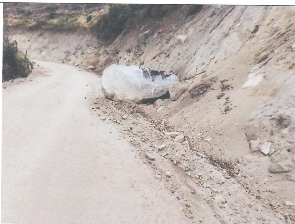
PROGRESIVA: 4+550 - 4+610. Cuneta obstruida por material de derrumbe.
