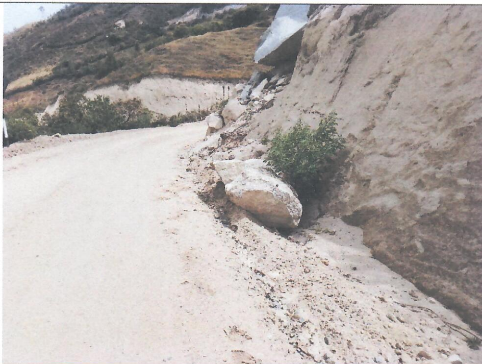
PROGRESIVA: 14+810 - 15+110. Cuneta obstruida por material de derrumbe.
