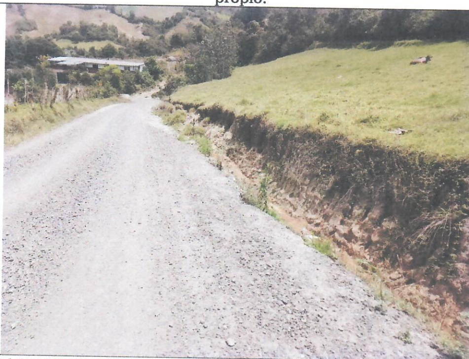
PROGRESIVA: 17+225 - 17+725. Cuneta obstruida por material de derrumbe y maleza.
