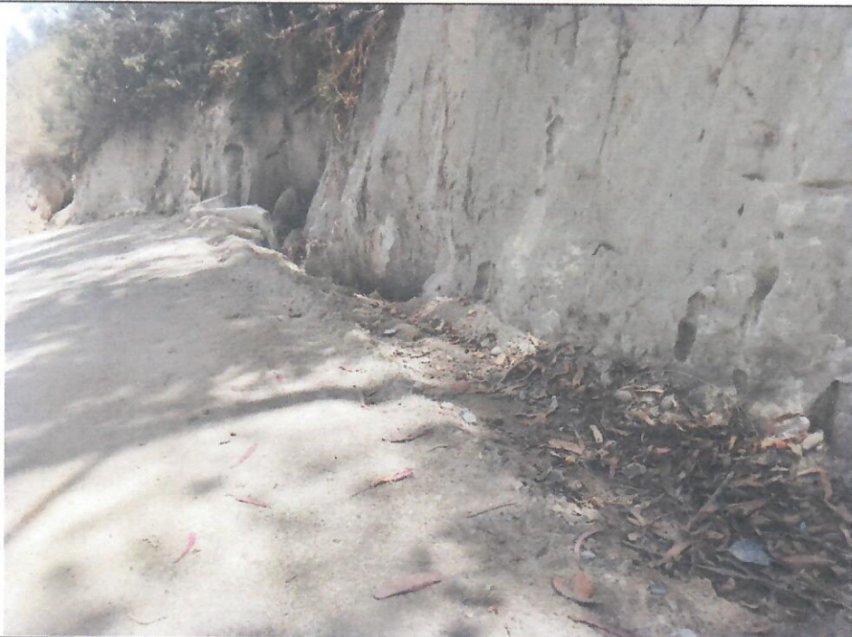
PROGRESIVA: 13+860 - 14+160. Cuneta obstruida por maleza.
