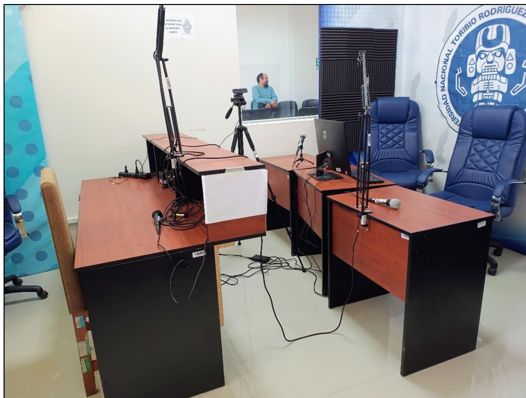
Imagen N°2: Vista de la cabina de radio, donde sus cerramientos (paredes, cielo raso y ventanas) no cuentan con un aislamiento acústico.
