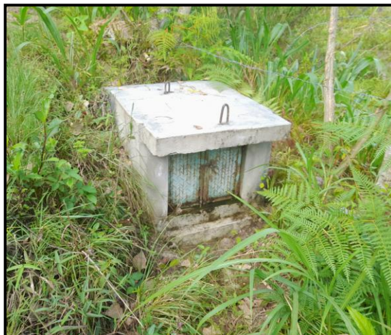
IMAGEN N° 6. Cámara Rompe Presión Tipo 6
