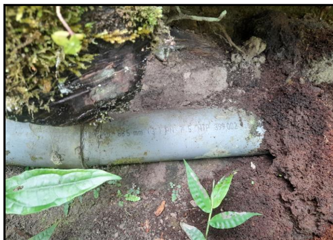
IMAGEN N° 7. Tubería de Línea de conducción Expuesta
