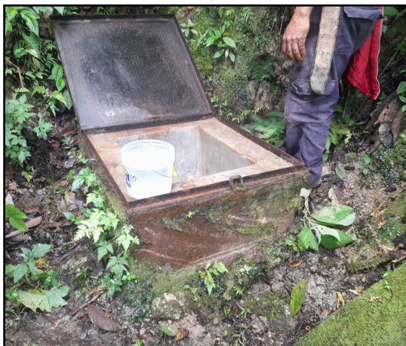
IMAGEN N° 2. Captación Existente Manantial Vista Hermosa 1
