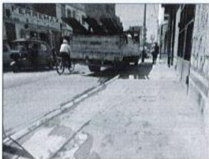
Sector intermedio de Av. Mariscal Cáceres de la cuadra 4. Inexistencia de sistemas de drenaje pluvial y veredas desgastadas.
