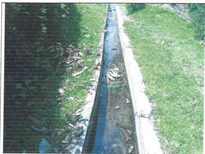
Fotografía N° 23: canal de forma rectangular 0.40*0.30m
