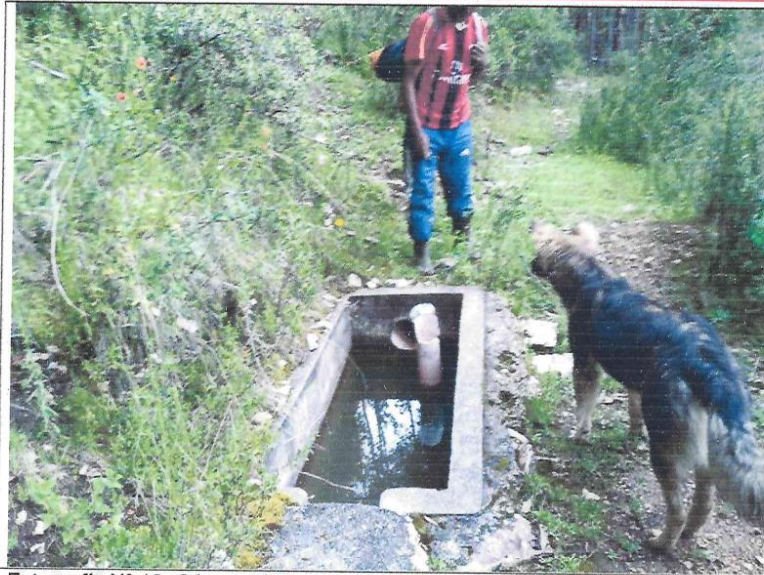
Fotografía N° 12: Cámara de inspección en línea conducción cerrado tubería, su estado operativo
