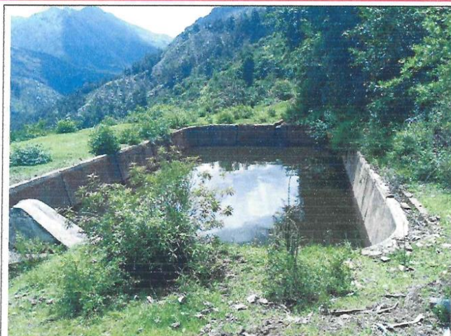
Fotografía N° 15: Reservorio existente cap: 317 m3, su estado operativo
