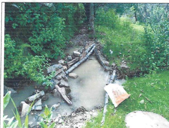
Fotografía N° 28: Desarenador artesanal de tierra en pésimas condiciones
