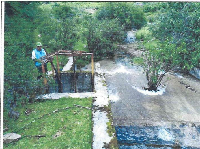
Fotografía N° 18: se observa compuerta en estado deteriorado se encuentra inoperativo
