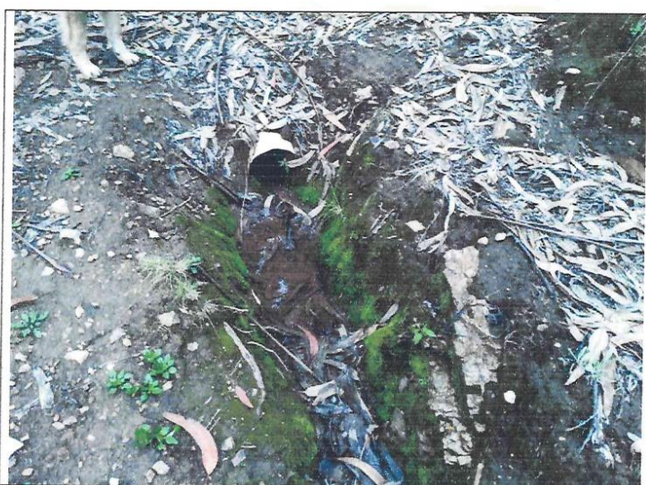
Fotografía N° 07: Vista panorámica de canal entubado con diámetro de 160mm
