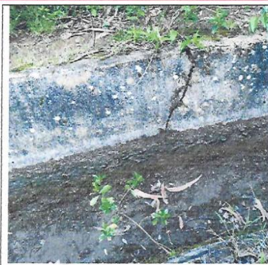
Fotografía N° 19: Fisura en lateral de canal
