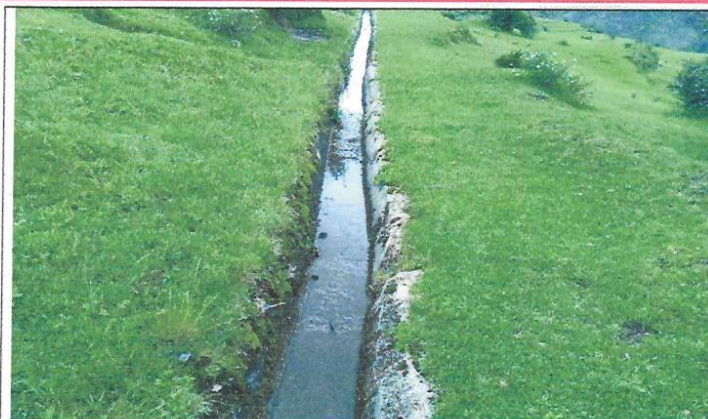
Fotografía N° 06: Vista panorámica de canal de concreto el segundo tramo tiene forma trapezoidal con medidas de 0.45*0.25*0.30m
