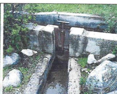
Fotografía N° 09: Compuerta de tipo de targeta
