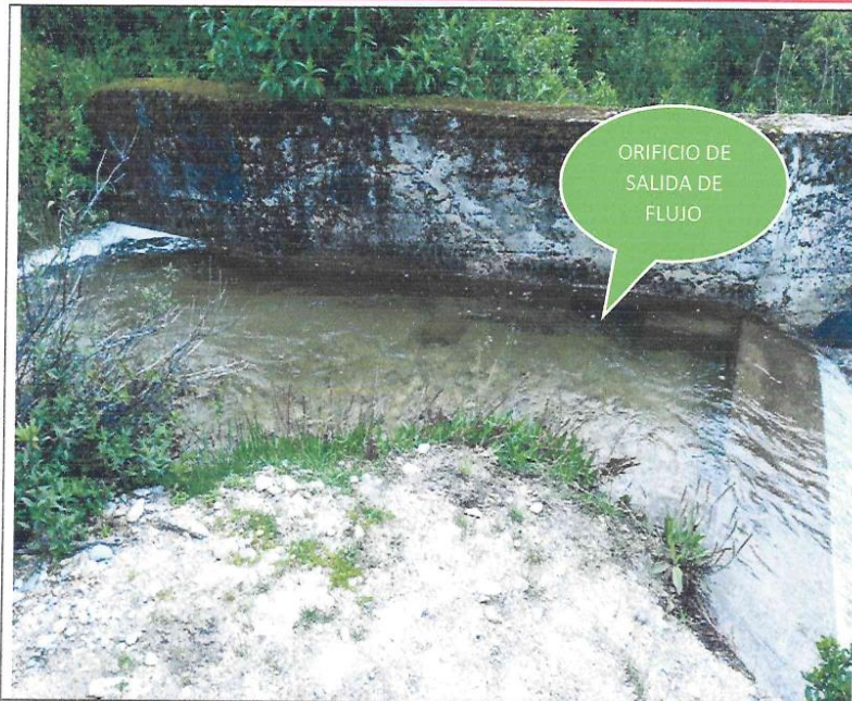
Fotografía N° 02: Vista panorámica de bocatoma en estado deterioro, no presenta compuerta solo un orificio para la salida de flujo
