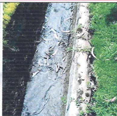
Fotografía N° 20: Colapso de base de canal
