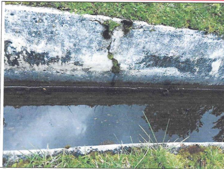
Fotografía N° 04: Se muestra base y lateral de canal concreto con fisuras
