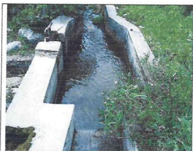
Fotografía N°08: Desarenador existente
