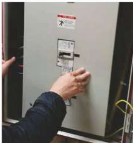
Interruptor 3x250A a reemplazar en tablero fuerza de cuarto de bombas
