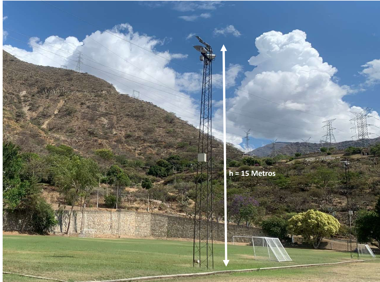
Fotografía N° 2: Altura de las torres existentes donde se instalarán las luminarias.
