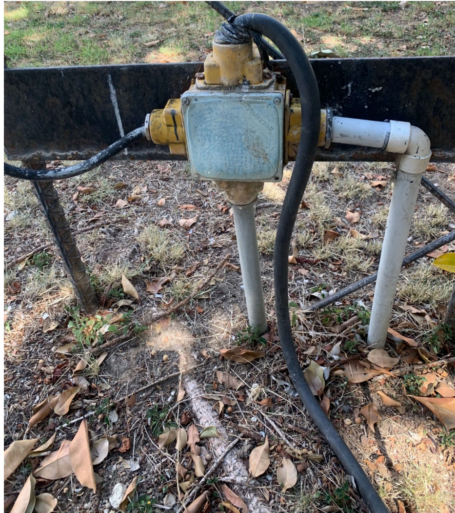
Fotografía N° 6: Cajas de paso existentes y borneras de conexión en su interior
