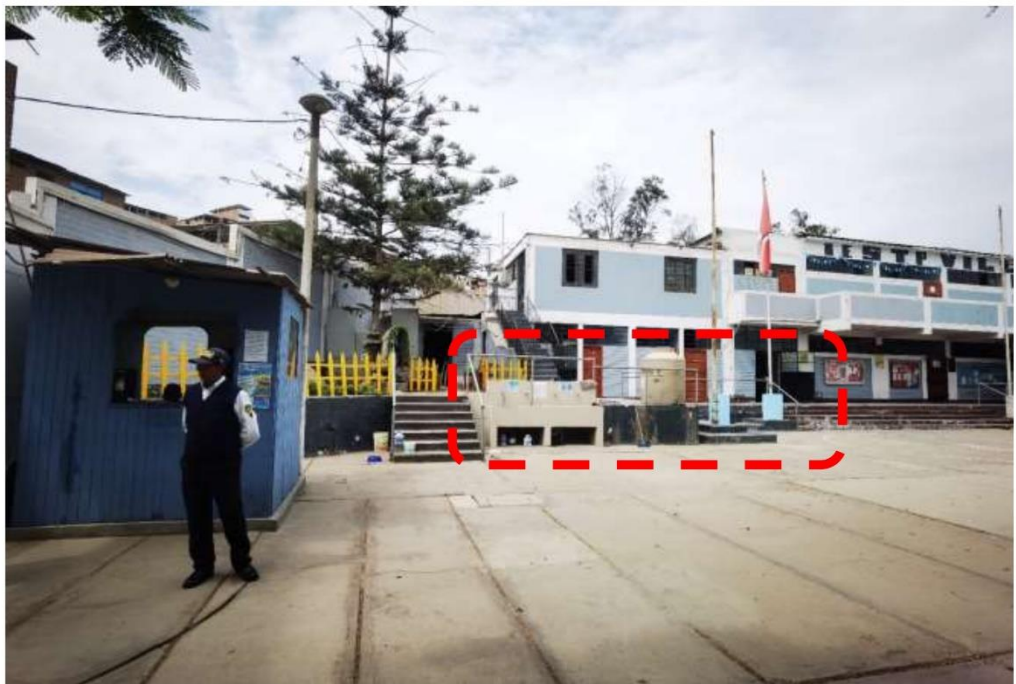
Fotografía N° 01.- Cuenta con desniveles entre plataformas de 15cm y se proyectó la Rampa N°01 y 02
