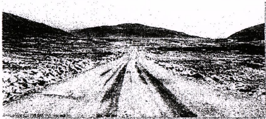
Foto N° 01: Deterioro por Deformación y Ahuellamiento de la superficie de rodadura
