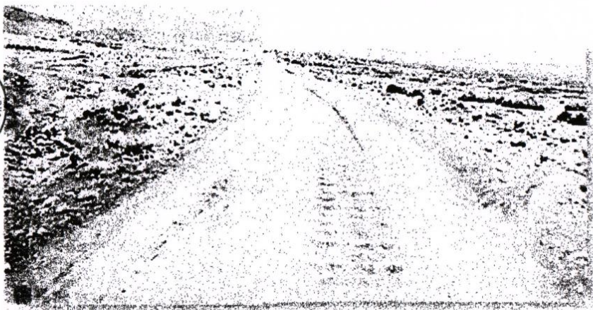
Foto N° 04 Presencia de zonas con fallas por Encalaminado de la vía
