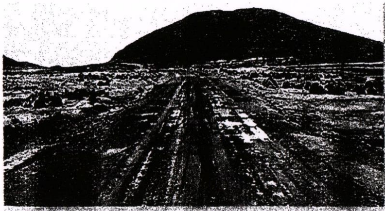
Foto N° 05 Presencia de lodazales, provocando deformaciones en la vía
