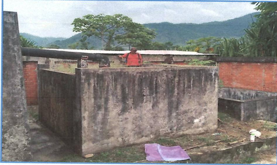
En la Foto N° 03, se observa el deterioro y mal estado de la planta de tratamiento de las aguas residuales. Asimismo, se observo que la cámara de filtrado de las aguas, se requiere el cambio de filtros y cambio de llaves
