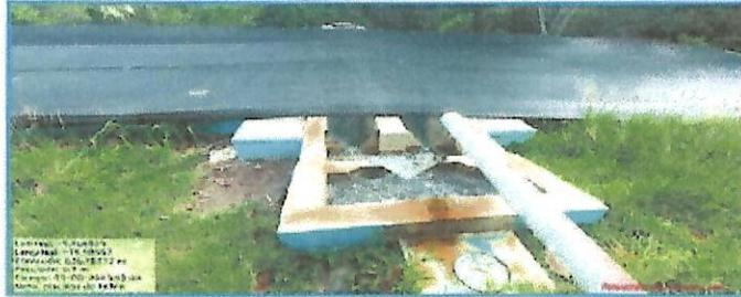
En la foto N° 01, se observa uno de los filtros de la Localidad de Naranjillo ubicado en la parte alta de Milagro de Dios, falta mejorar la cubierta de las piscinas, colocar compuertas de metal con malla para evitar el ingreso de animales y suciedad.
