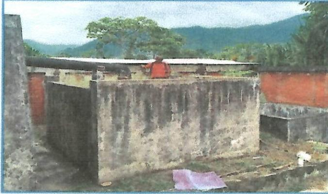
En la Foto N° 03, se observa el deterioro y mal estado de la planta de tratamiento de las aguas residuales. Asimismo, se observó que la cámara de filtrado de las aguas, se requiere el cambio de filtros y cambio de lavas
