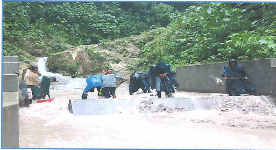
En la foto N° 02, se observa la infraestructura de la captación agua ubicado en Milagro de Dios, en condiciones donde se almacena inmediatamente la arena, se requiere implementar un mejor diseño para evitar el acumulamiento de arena.
