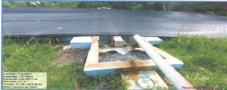
En la foto N° 01, se observa uno de los filtros de la Localidad de Naranjillo ubicado en la parte alta de Milagro de Dios, falta mejorar la cubierta de las piscinas, colocar compuertas de metal con malla para evitar el ingreso de animales y suciedad.
