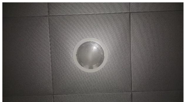
**Instalación de luminarias base circulares empotrables al cielo raso drywall de paneles o placas de yeso, área mezanine de la sala naciones 1 a una altura de 3 metros aproximadamente.**
