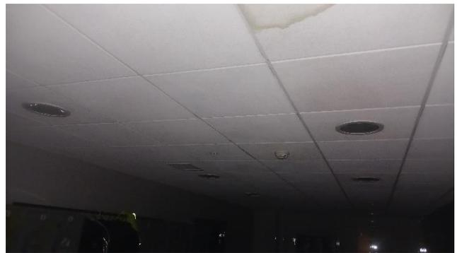
**Instalación de luminarias de base cilíndrica blanco suspendidas del techo en pasadizos, hall interno de los sótanos a una altura de 3 metros aproximadamente.**
