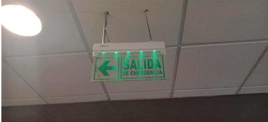
**Instalación de equipos de señaléticas iluminadas con texto de salida en el ingreso de las puertas de emergencia para las escaleras de evacuación**
