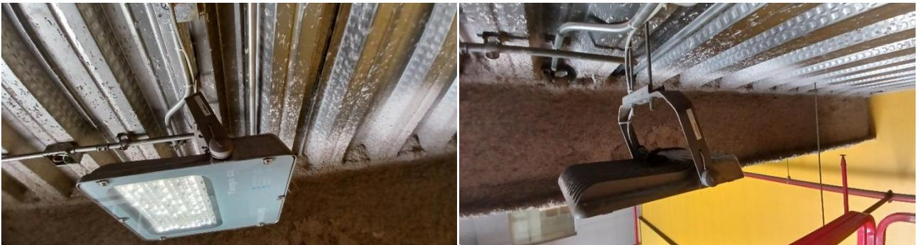
**Instalación de luminarias tipo reflectores LED zona rampa ingreso al sótano 1 altura 10 metros aproximadamente.**
