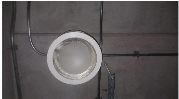
**Instalación de luminarias base circulares empotrables al cielo raso de acero tipo inox mate perforado al ingreso de las salas lima 1 y 2 a una altura de 3 metros aproximadamente.**
