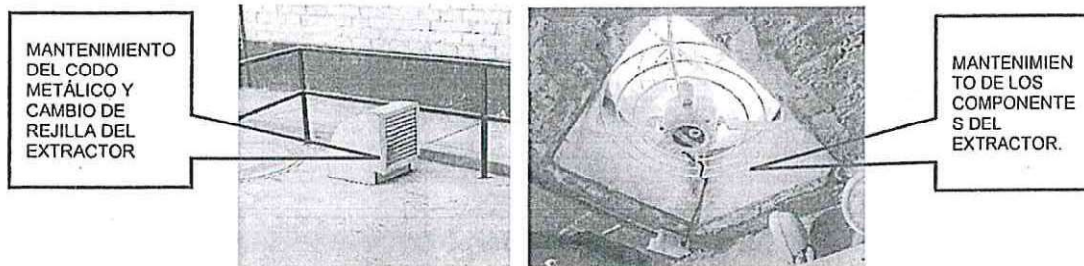
IMÁGENES 12 y 13 – MANTENIMIENTO INTEGRAL DE LOS COMPONENTES DEL EXTRACTOR E INYECTOR EXISTENTES EN EL CUARTO DE BOMBAS
