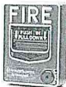
IMÁGENES REFERENCIALES 96, 97, 98 y 99 –DISPOSITIVOS DEL SISTEMA DE ALARMA Y DETECCIÓN DE INCENDIOS.
