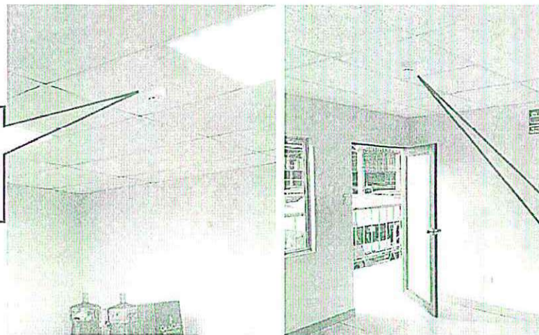
IMÁGENES 52 Y 53 – REMOCIÓN E INSTALACIÓN DE DETECTORES DE HUMO CONVENCIONALES
