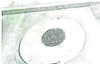
IMAGEN 18- TAPA METÁLICA DE CUARTO DE BOMBAS CONTRA INCENDIO
