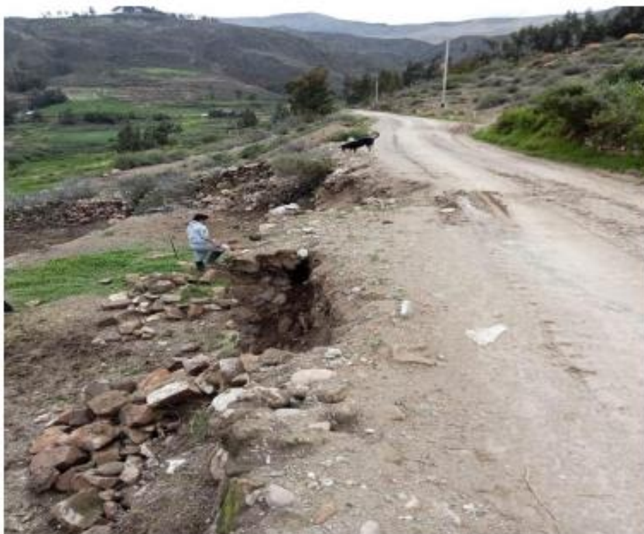
REPARANDO MANUALMENTE LOS DERRUMBES OCASIONADO POR LAS FILTRACIONES
