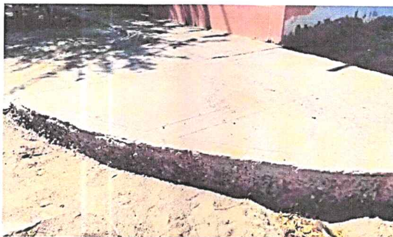
Fotografía 02: Esquina de vereda (perpendicular a calle en estudio) en mal estado - Tramo 2 de la Calle la Victoria.
