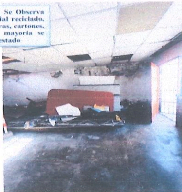
FOTOS N°03 y N°04: Se observa la presencia de daños severos del techo existente, por la antigua construcción
