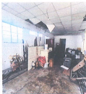
FOTOS N°03 y N°04: Se observa la presencia de daños severos del techo existente, por la antigua construcción
