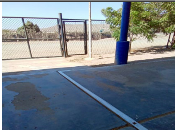
FOTO N° 02: SE MUESTRA PARTE DE LA MALLA DEL CERCO PERIMETRICO Y LA LOSA EN MAL ESTADO DE CONSERVACIÓN.
