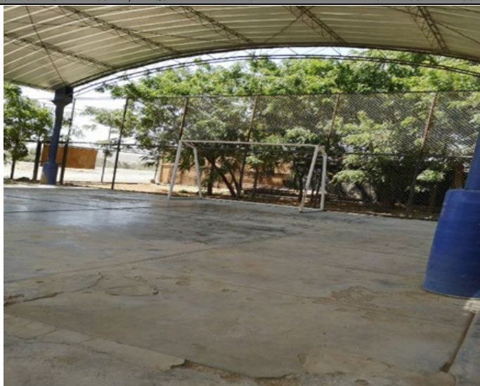
FOTO N° 4: SE MUESTRA LA LOSA DEPORTIVA EN MAL ESTADO DE CONSERVACIÓN.
