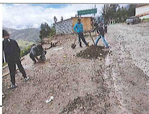
Excavaciones en la Calicata C-03 en la progresiva 03+210
