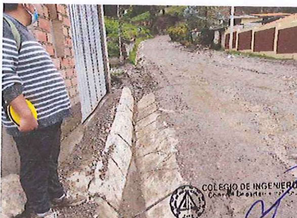
Progresiva 01+350 se muestra el desprendimiento del Pavimento, y la erosión de la Base Granular.
