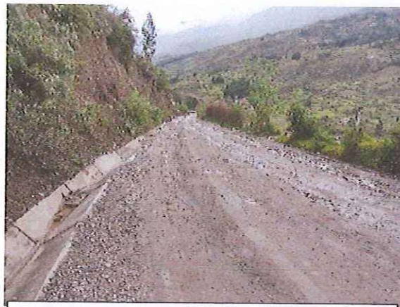
Progresiva 0+650, Desprendimiento de la Capa de Rodadura en la Calzada.
