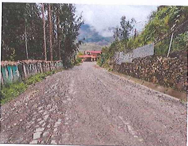
Progresiva 03+520: se observa la falla de desprendimiento del Pavimento que ha llegado hasta el nivel de la base granular.
