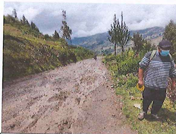
Progresiva 03+780: se observa la falla de desprendimiento del pavimento y la erosión de la Base Granular.
