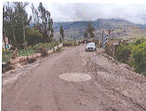
Progresiva 04+190 se observa una falla de desprendimiento total del pavimento y la erosión severa de la base granular.
