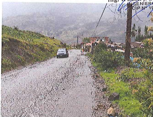
Progresiva: 02+620 se observa la falla tipo piel de cocodrilo en el Pavimento.
