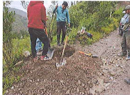
Excavaciones de la Calicata C-01, en la progresiva 0+510
