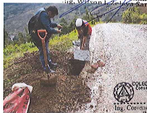
Excavaciones y Muestreo en la Calicata C-02 en la progresiva 02+240
