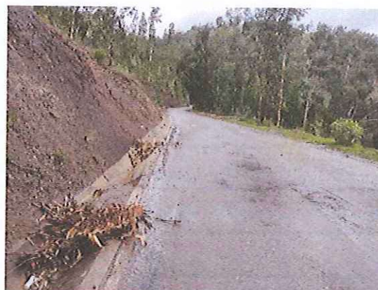
Progresiva 02+080 se observa baches en la superficie de rodadura.
