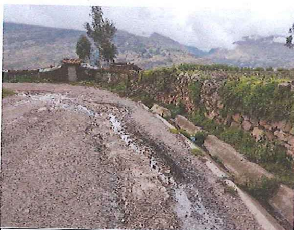
Progresiva 04+140 se observa una falla de desprendimiento total del pavimento y la erosión severa de la base granular.
