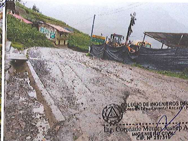
Progresiva 02+740: se observa la falla de desprendimiento del pavimento y la erosión de la base granular.
