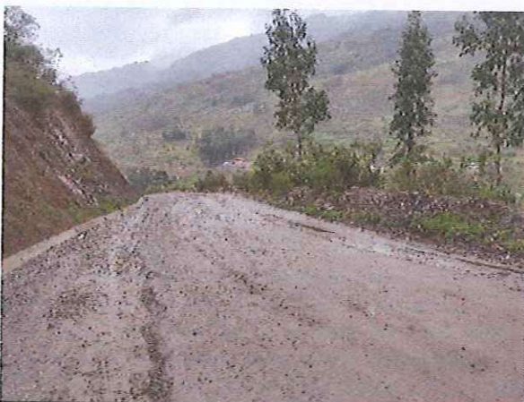
Progresiva 00+080, obsérvese el desprendimiento de la capa de Pavimento.
