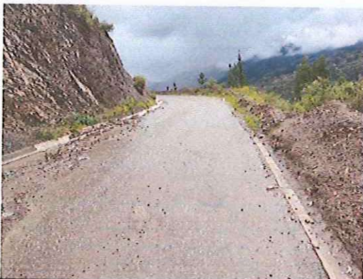
Progresiva 1+530 se observa fallas de fisura miento longitudinal en la superficie pavimentada.
