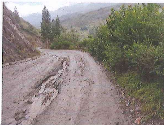
Progresiva 00+440: Desprendimiento total de la capa de rodadura y la erosión de la base granular.
