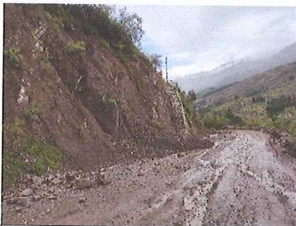
Progresiva 00+560: Desprendimiento total de la capa de rodadura y la erosión de la base granular, Cunetas totalmente colmatadas.
