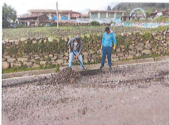
Excavaciones y mediciones de los espesores de la estructura del pavimento existente en la progresiva 04+160
