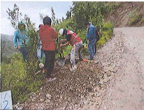
Excavaciones de la Calicata C-01, en la progresiva 0+510
