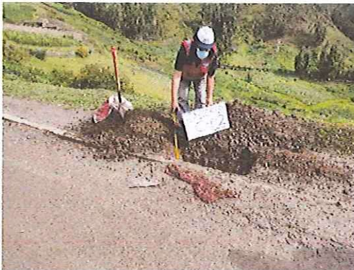
Excavaciones y Muestreo en la Calicata C-02 en la progresiva 02+240
