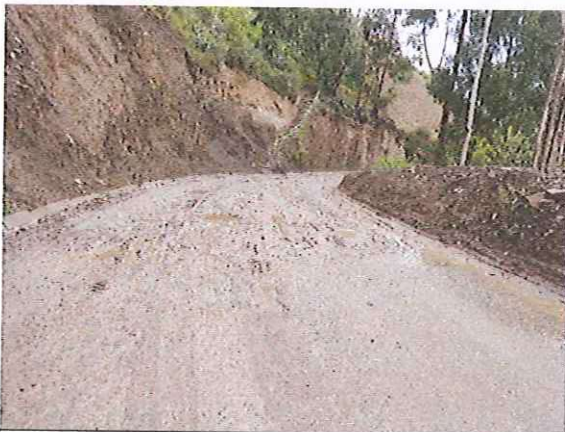
Progresiva 00+920; se observa los baches en la superficie de rodadura.
