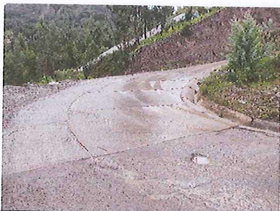
Progresiva 02+210 se observa Baches en la unión del Pavimento Flexible y el Pavimento Rígido en las curvas de volteo.
