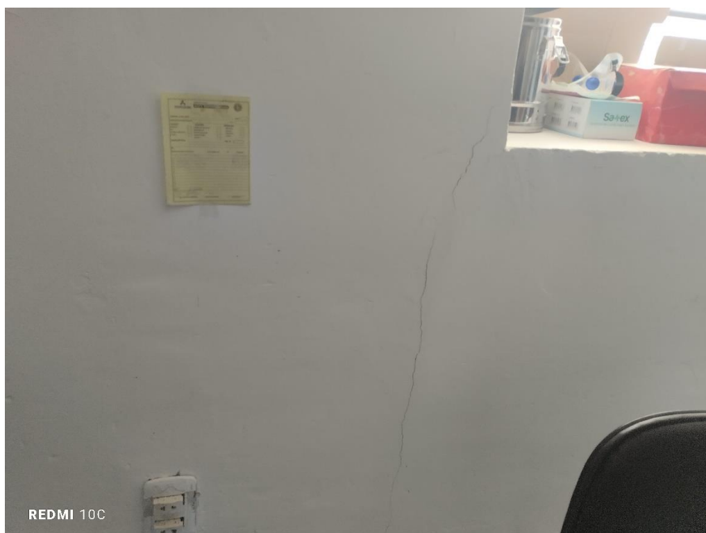
FOTO N°10 : MUROS DETERIORADAS CON FISURA
