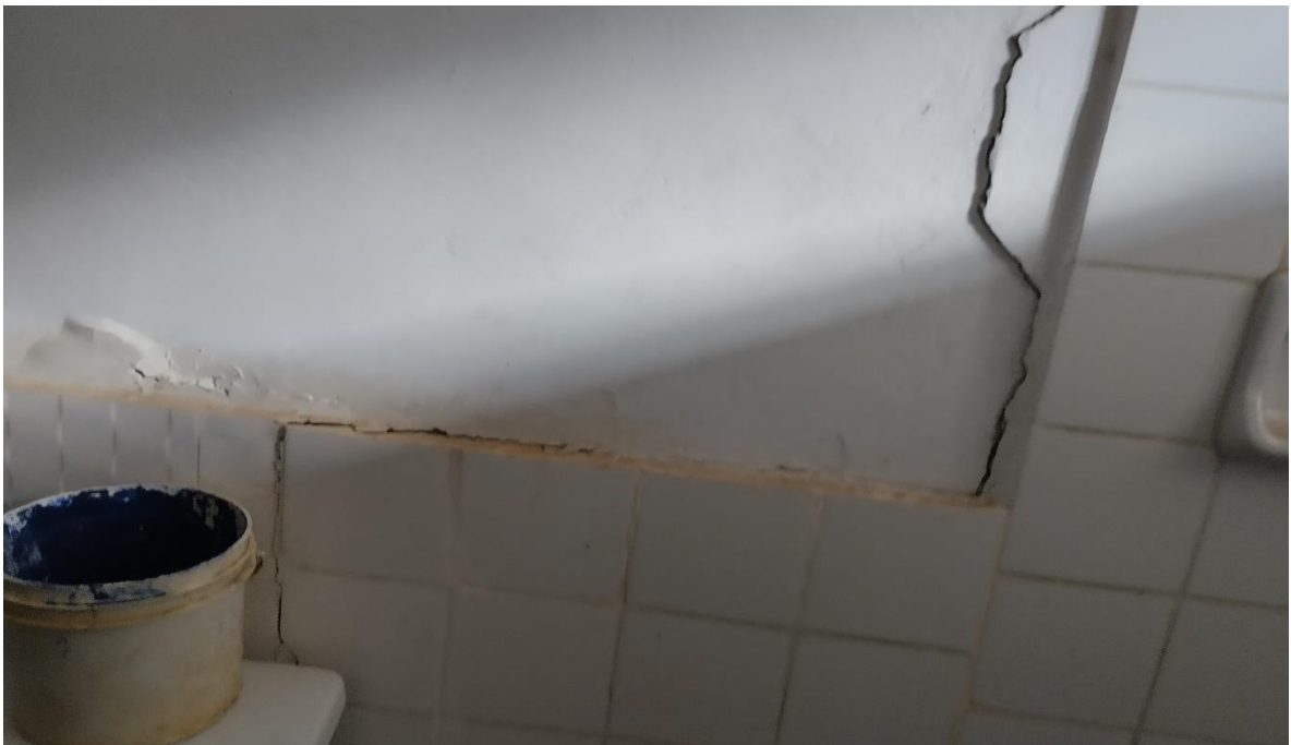
FOTO N°08: FISURAS EN MUROS
