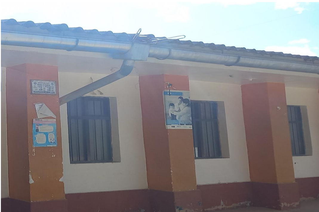
FOTO N°06: MONTANTES DETERIORADOS
