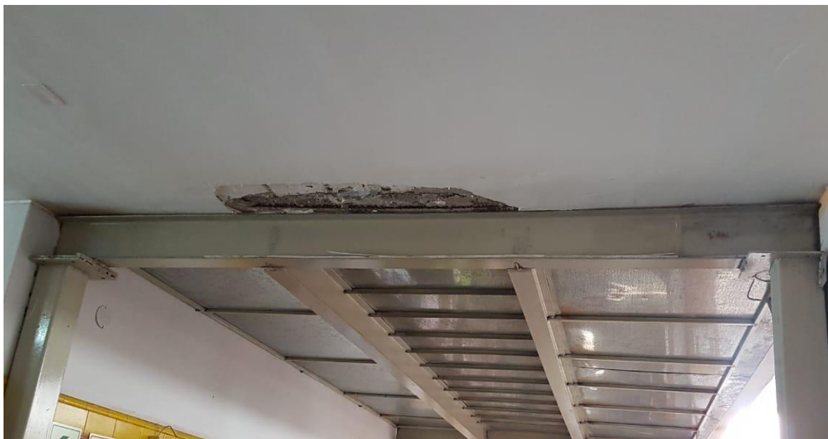
Imagen 01: Desprendimiento de los elementos de la losa aligerada.
