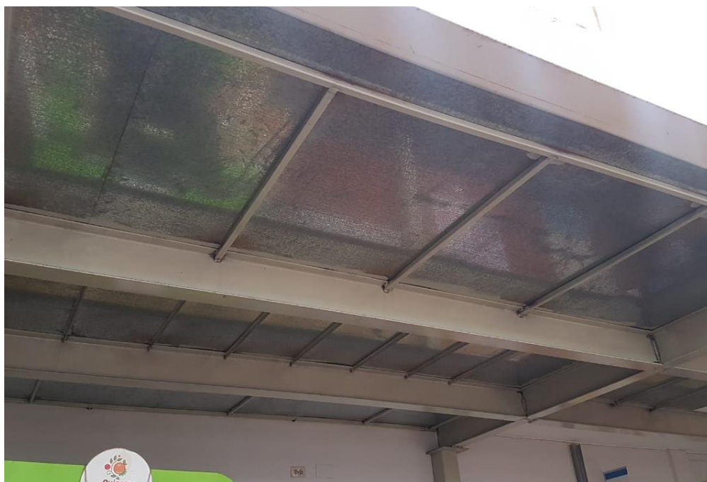
Imagen 05: Deterioro de planchas de acero y falta de baldosas.
