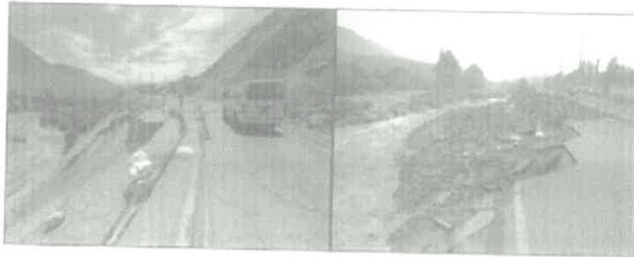
Fotografías 01 y 02: Se ha erosionado el pie del talud ocasionando la pérdida de la plataforma de la vía por incremento del caudal del río.
