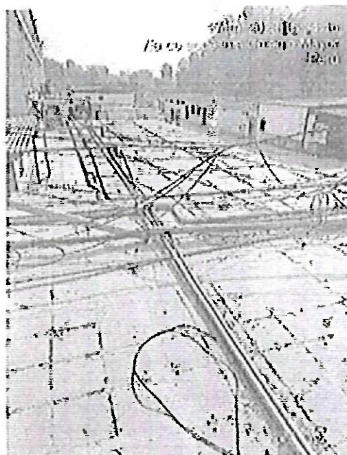
Imagen N°3: techo a intervenir de la cocina la cual se encuentra en mal estado y tiene filtraciones – cables tendidos sin orden
