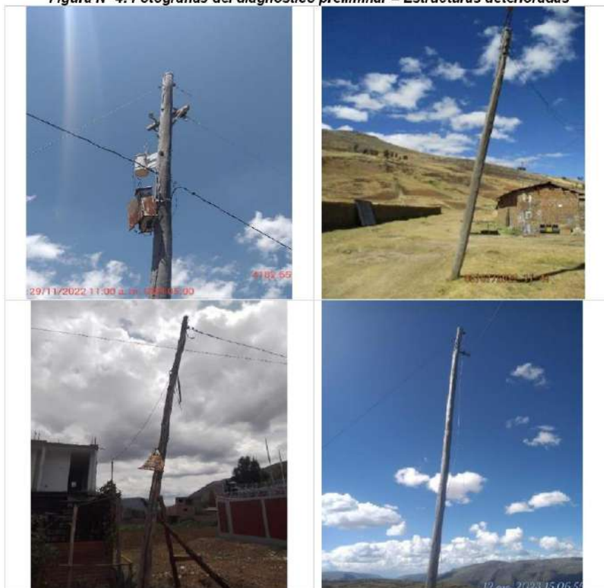
Figura N° 4: Fotografías del diagnóstico preliminar – Estructuras deterioradas
