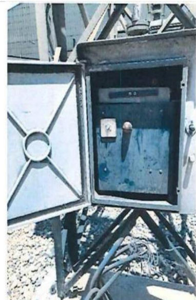
Fig. 5 Canalización y cable de control averiados
