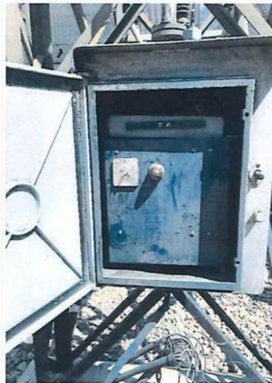
Fig. 1 Caja de control del seccionador lleno de suciedad
