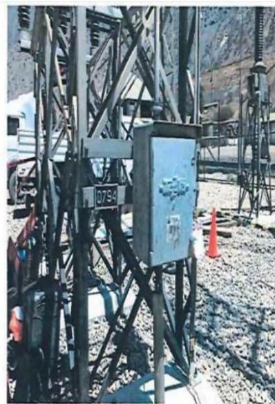
Fig. 6 Casi el íntegro del soporte esta con inicios de corrosión.
