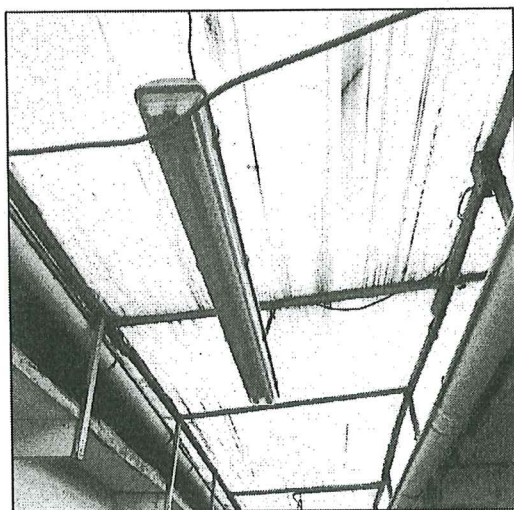
FOTO N° 04: LUMINARIAS AMARILLENTAS, REQUIEREN CAMBIO Y MEJORAMIENTO EN SU INSTALACIÓN
