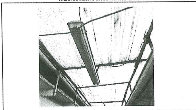
FOTO N° 06: BLOQUE 4, CANALETAS PLUVIALES DETERIORADAS, DESCOLGADAS, Y DESALINEADAS POR LO QUE NO PERMITEN LA EVACUACIÓN DE LAS AGUAS PLUVIALES DE MANERA CORRECTA GENERANDO ACUMULACIONES
