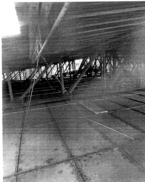
Estructura metálica de cubierta con presencia de óxido por falta de mantenimiento
