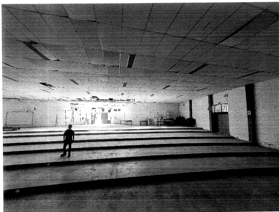
Falso cielorrasos dañados, pisos deteriorados, luminarias dañadas y oxidadas.
