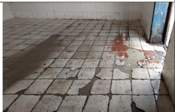
Foto N°04 : Se observa pisos en mal estado
