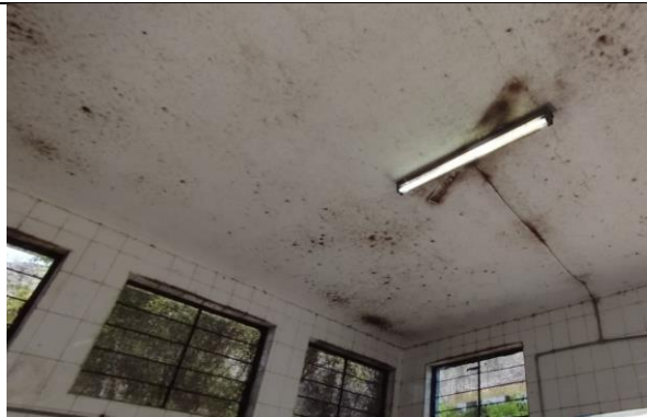
Foto N° 01: Se observa hongos en cielo raso
