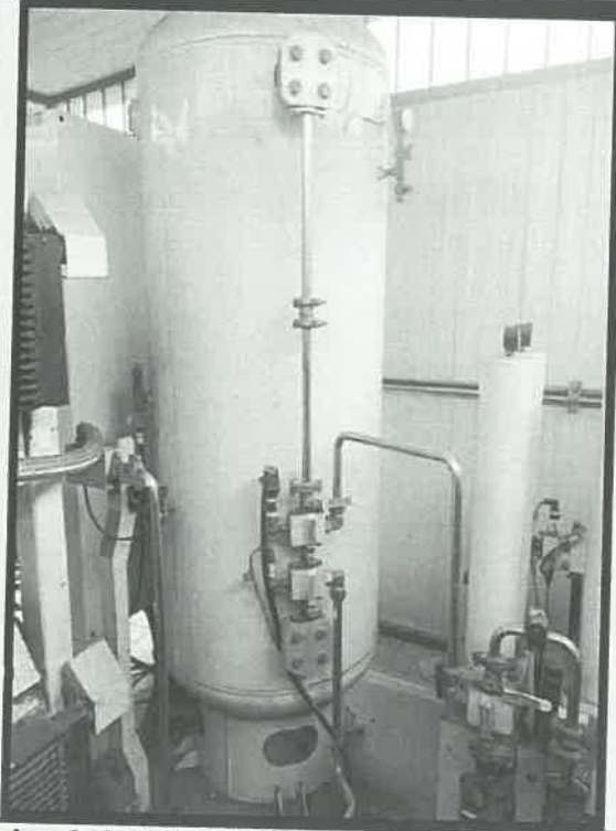
Equipo de Aire Comprimido Medicinal del CETIDE inoperativo
