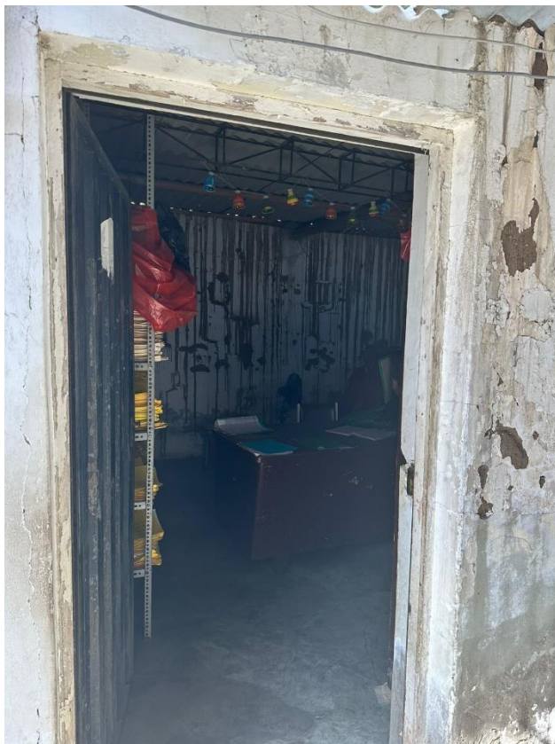
FOTOGRAFÍA N° 3.- EN ESTE AMBIENTE LA PARED HA SIDO AFECTADA POR LA LLUVIA, POSEE UNA COBERTURA DE TR4 QUE SE ENCUENTRA MAL INSTALADA.
