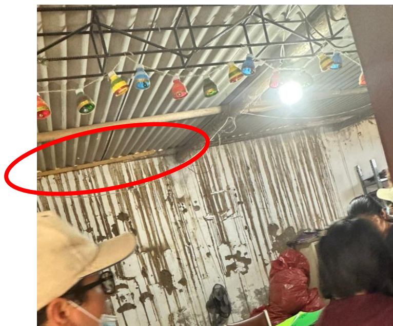
FOTOGRAFÍA N° 4.- TR4 MAL INSTALADO LO CUAL PERMITE QUE EN LAS UNIONES EXISTA EL FILTRADO DE AGUA.
