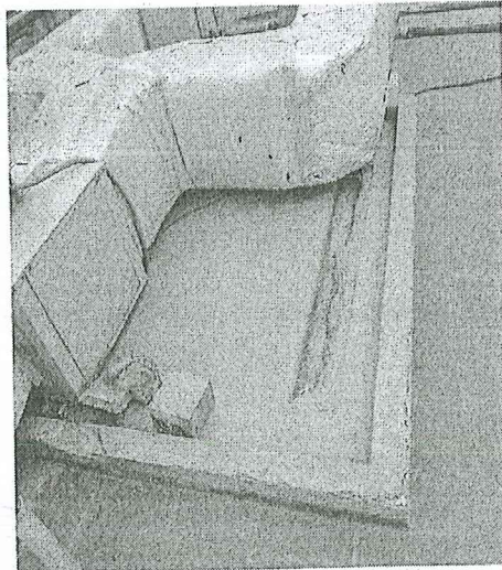
Foto 01: BASE DE CONCRETO PRESENTA FISURAS , PUDIENDO OCASIONAR FILTRACION DE AGUA DEBIDO A LLUVIAS.
