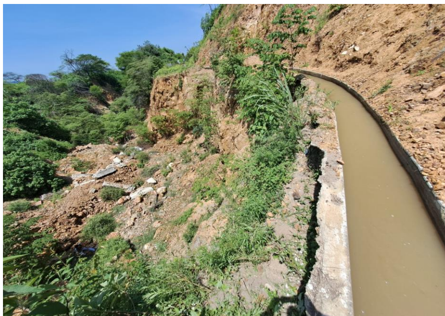
Fotografía N° 01: Canal rectangular – Talud erosionado lado lateral
