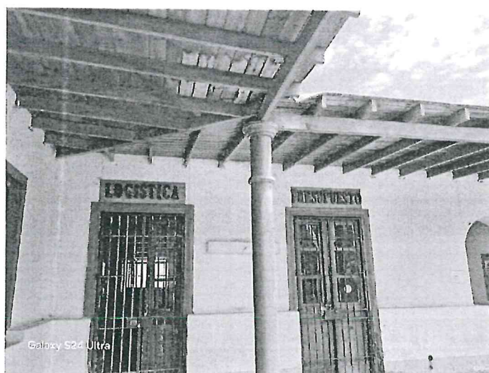
Fotografía N°06: Cobertura de techo en mal estado
