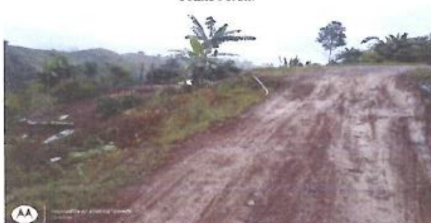
Fotografía N° 2: Pérdida de pendiente transversal y ahuellamiento Pérdida de pendiente Transversal
