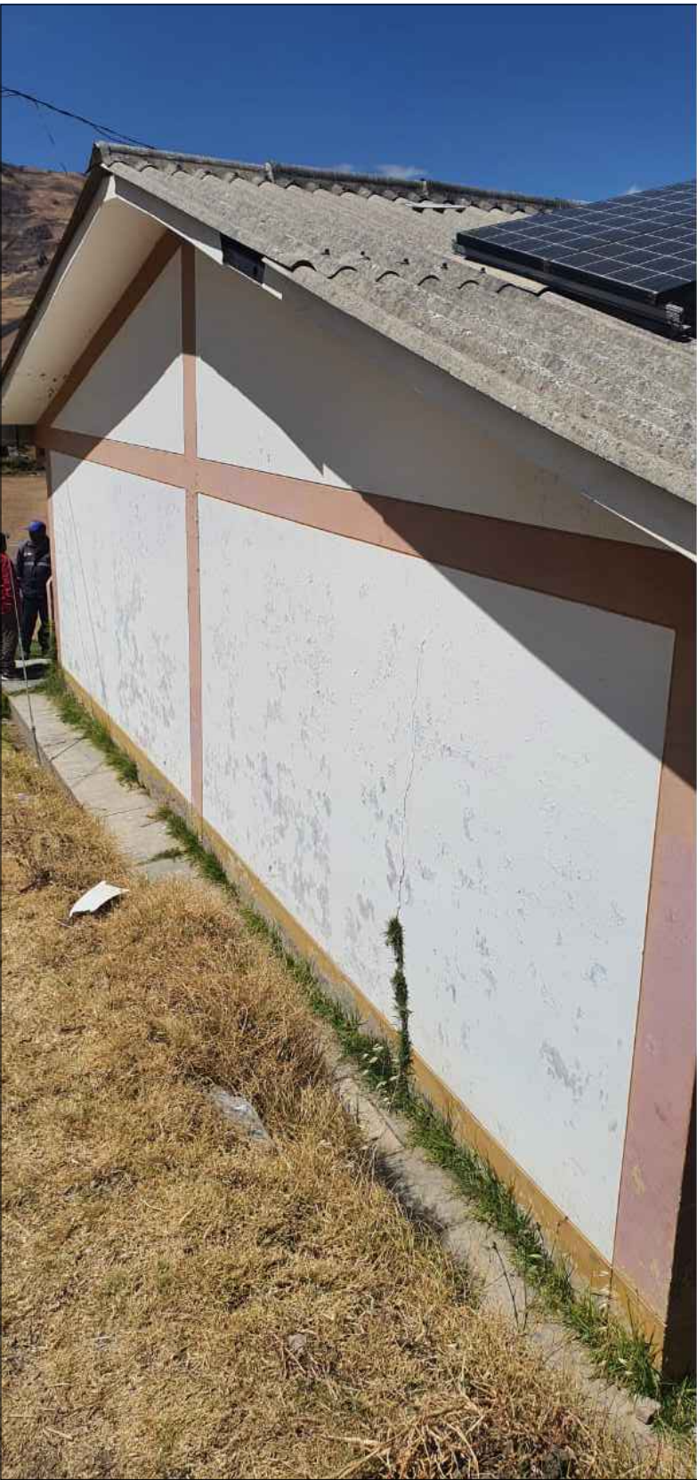
FOTO 06: Colocación de plancha de aluzin tipo tr4
