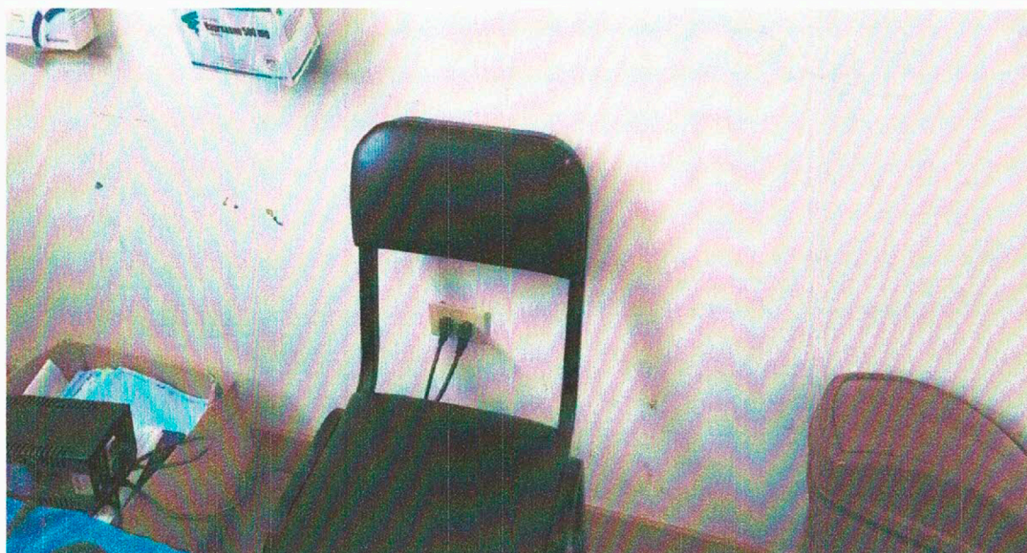
Foto 10. Se observa tomacorrientes en mal estado
