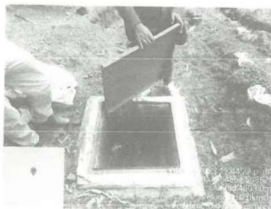
VISTA DE CAMARA DE PURGA EN MAL ESTADO DE CONSERVACION TAPA OXIDADA Y VALVULA EN MAL ESTADO
